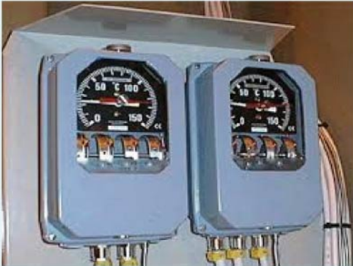
চিত্রঃ অয়েল ও উইভিং টেম্পারেচার ইন্ডিকেটর
