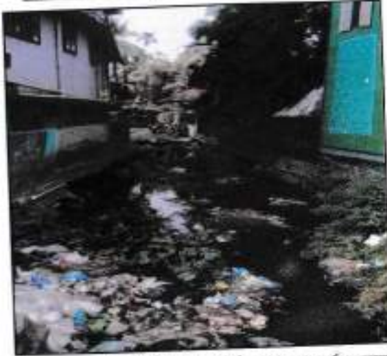
ছবি ১৪: সোবহানীঘাট (১৫ নং ওয়ার্ড), ময়লা-আবর্জনা ফেলার কারনে বন্ধ খাল/ছড়া/ড্রেনের চিত্র, সোবহানীঘাট পয়েন্ট (১৪ মার্চ ২০১৭)
