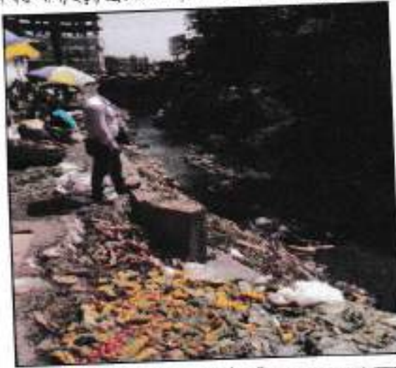
ছবি ১৬: চলিকন্দর (১৫ নং ওয়ার্ড), কাঁচাবাজার সংলগ্ন ড্রেন ময়লা-আবর্জনা ফেলার কারনে বন্ধ খাল/ছড়া/ড্রেনের চিত্র (১৪ মার্চ ২০১৭)
