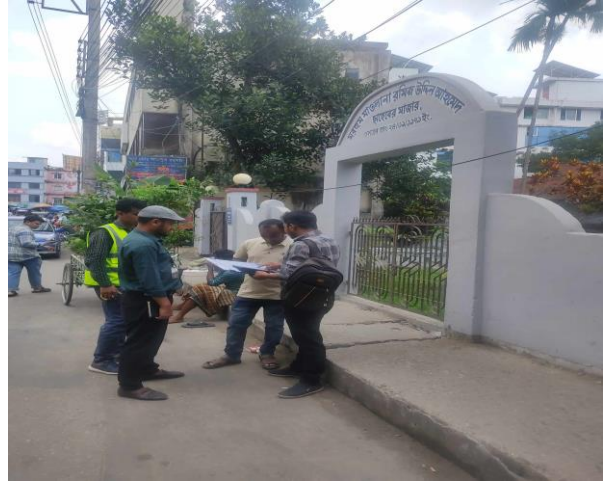
চিত্র-২: ওসমানী মেডিক্যাল এলাকার কাজ পরিদর্শন।
