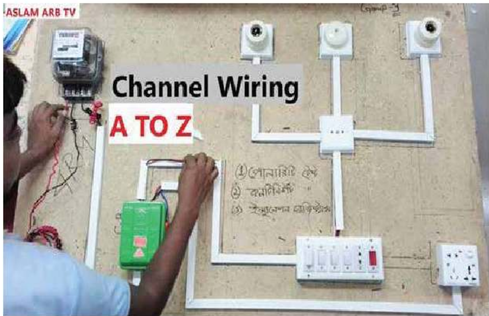
চিত্র-২.১৮ ১টি এনার্জি মিটার, ১টি মেইনসুইচ, ১টি ফ্যান, ২টি বাতি ও ১টি কন্ট্রোল সকেট নিয়ন্ত্রণের চ্যানেল ওয়্যারিং
