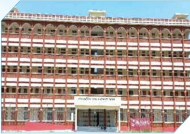
হোসেনাবাদ টেকনিক্যাল স্কুল ও কলেজ এর নবনির্মিত ৫তলা ভবন
