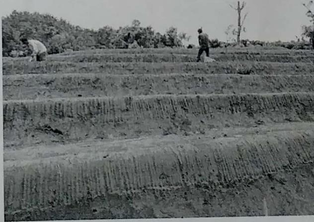
চিত্রঃ পাহাড়ী ঢালে আড়াআড়ি ধাপ তৈরির প্রক্রিয়া
