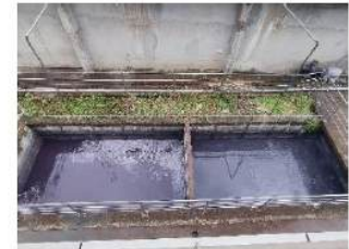
Fig. 3 Effluent inlet
