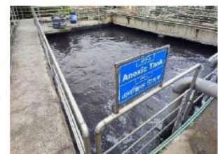
Fig. 9 Anoxic tank
