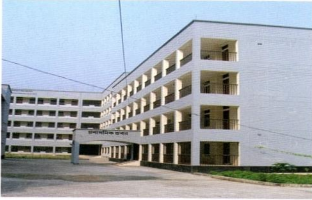
প্রশাসনিক ভবন, ফরিদপুর ইঞ্জিনিয়ারিং কলেজ, ফরিদপুর
