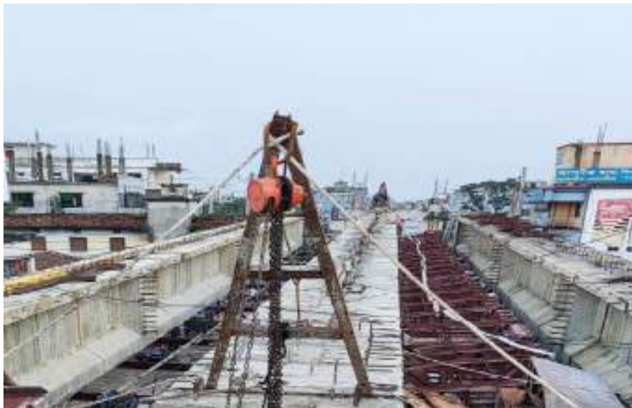
জামালপুর জেলা শহরের গেইটপাড় নামক স্থানে নির্মাণাধীন রেলওয়ে ওভারপাস
