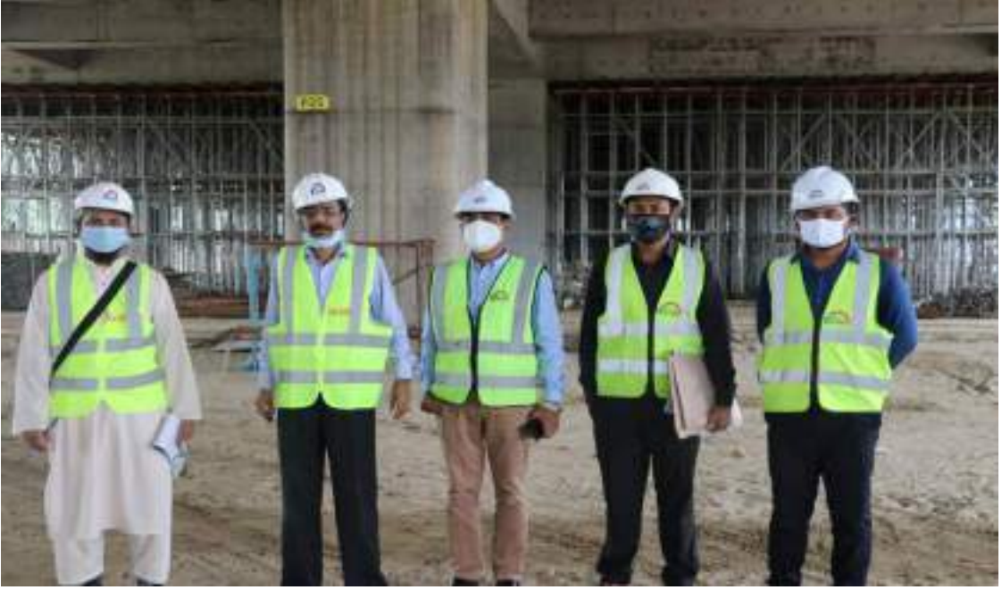
টিমসহ পরিদর্শক কর্তৃক ২৪ সেপ্টেম্বর ২০২০ তারিখে মেট্রোরেল লাইন-৬ এর উত্তরা নর্থ স্টেশন পরিদর্শন
