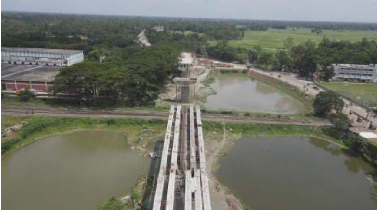
উল্লাপাড়া রেলওয়ে ওভারপাস নির্মাণ প্রকল্পের চলমান কাজ
