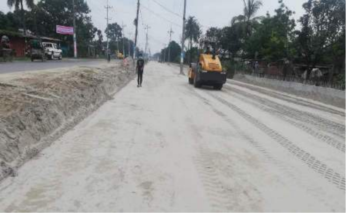
রাজশাহী-নওহাটা-চৌমাসিয়া সড়কের বিন্দুর মোড় নওহাটা ব্রিজ পর্যন্ত মহাসড়কের চলমান কাজ
