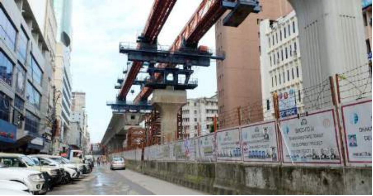
মতিঝিল এলাকায় ভায়াডাক্ট Erection এর কাজ চলছে
