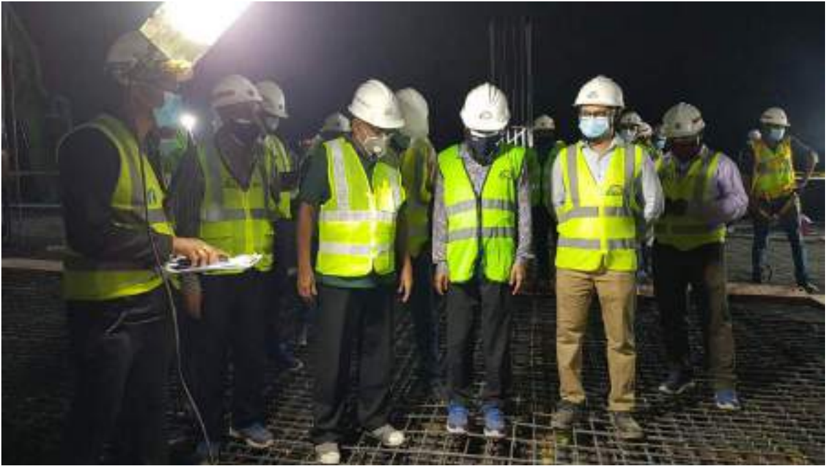
ব্যবস্থাপনা পরিচালক কর্তৃক ০১ এপ্রিল ২০২১ তারিখ মধ্যরাতে ঢাকা বিশ্ববিদ্যালয় স্টেশনের Concourse ছাদ ঢালাই এর কাজ আকস্মিক পরিদর্শন
