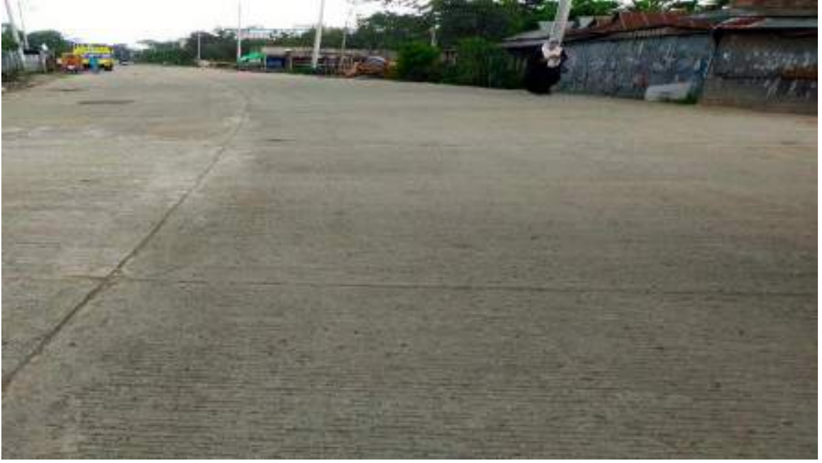
কিশোরগঞ্জ-করিমগঞ্জ-চামড়াঘাট জেলা মহাসড়কে রিজিড পেভমেন্ট নির্মাণ
