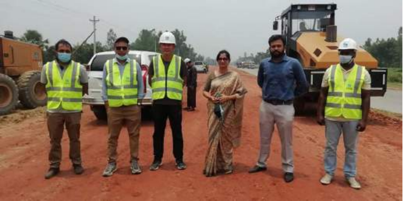
মনিটরিং টিম প্রধান সুলতানা ইয়াসমীন কর্তৃক সাসেক-II প্রকল্পে বগুড়া-রংপুর মহাসড়কাত্মশে নির্মাণ কাজ পরিদর্শন
