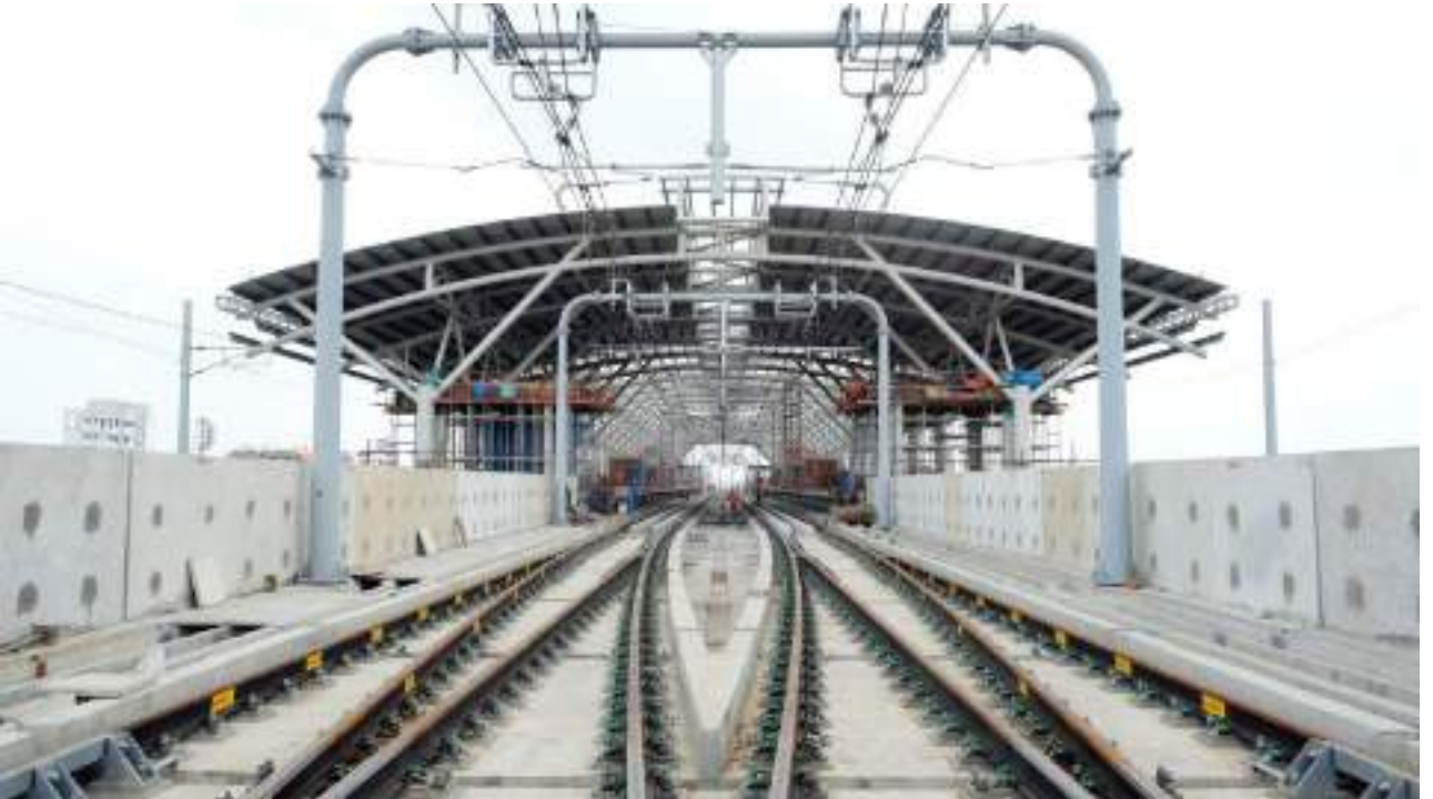
নির্মাণাধীন উত্তরা উত্তর মেট্রোরেল স্টেশনে স্থাপিত রেলওয়ে ট্র্যাক ও Overhead Catenary System
