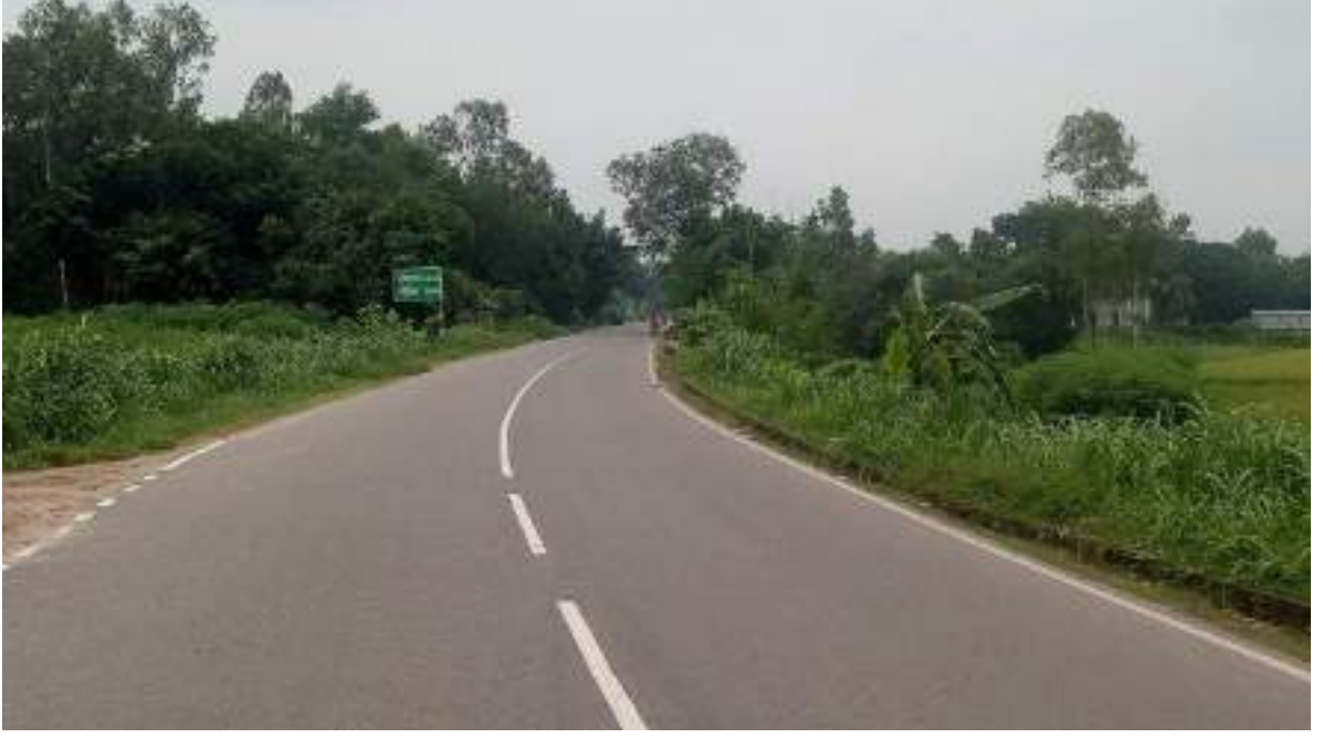
হেমায়েতপুর-সিংগাইর-মানিকগঞ্জ আঞ্চলিক মহাসড়ক যথাযথ মান ও প্রশস্ততায় উন্নয়ন প্রকল্প
