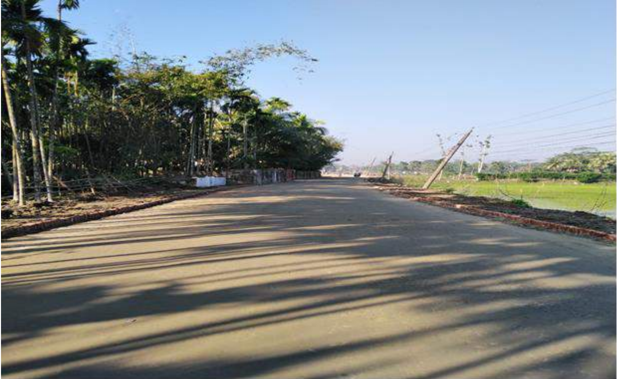
মাইজদী-রাজগঞ্জ-ছয়ানী-বসুরহাট-চন্দ্রগঞ্জ আঞ্চলিক মহাসড়ক উন্নয়ন প্রকল্পের চলমান কাজ
