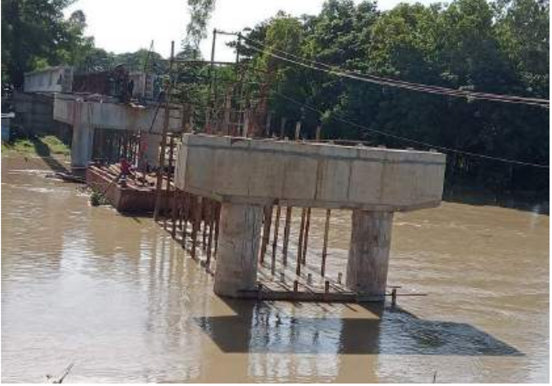
গাছবাড়ীয়া-চন্দনাইশ-বরকল-আনোয়ারা সড়কের চাঁদখালী নদীর উপর বরকল সেতু নির্মাণ প্রকল্পের চলমান কাজ
