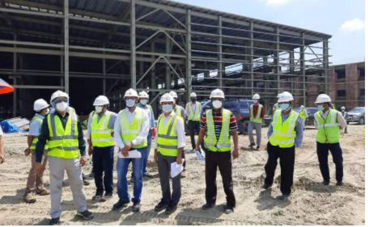
প্রকল্প পরিচালক, এমআরটি লাইন-৬ কর্তৃক উত্তরা ডিপোর নির্মাণ কাজের অগ্রগতি পরিদর্শন
