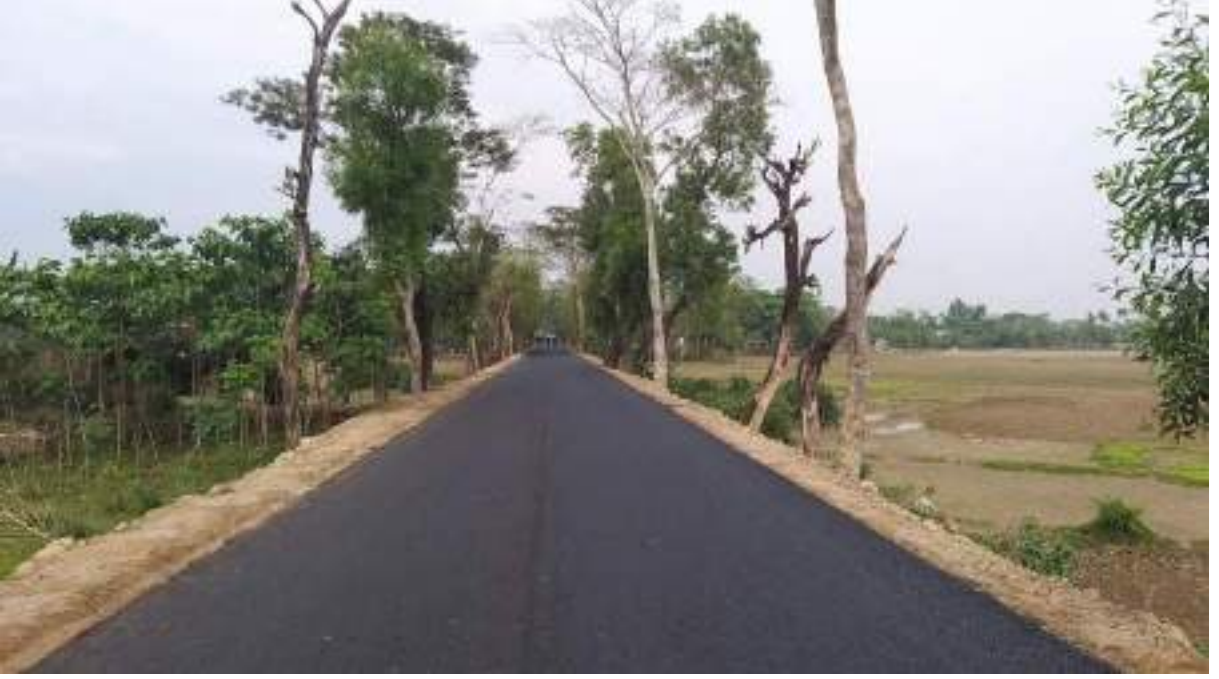
সারী-গোয়াইনঘাট জেলা মহাসড়কে চলমান কাজের স্থিরচিত্র
