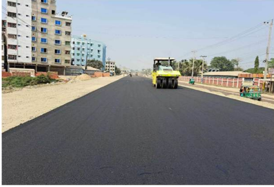
আশুগঞ্জ নদীবন্দর-সরাইল-ধরখার-আখাউড়া স্থলবন্দর মহাসড়ক উন্নয়ন প্রকল্পের চলমান কাজ
