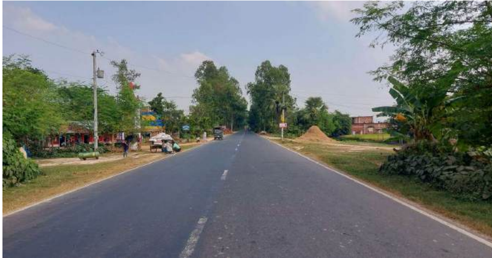
প্রকল্পের আওতায় মোকামতলা-কলাই-জয়পুরহাট (আর-৫৫০) মহাসড়কের সার্ফেসিং কাজ
