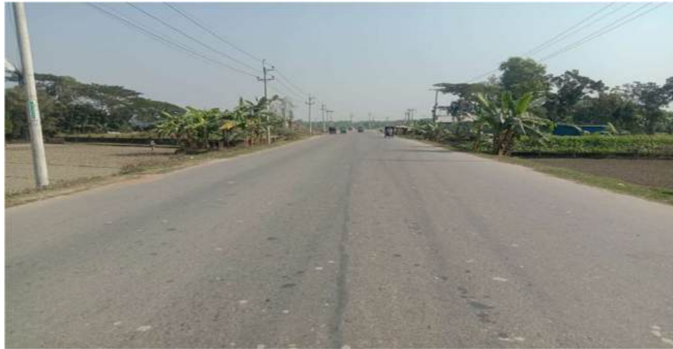
কিশোরগঞ্জ-করিমগঞ্জ-চামড়াঘাট জেলা মহাসড়কের চলমান কাজ
