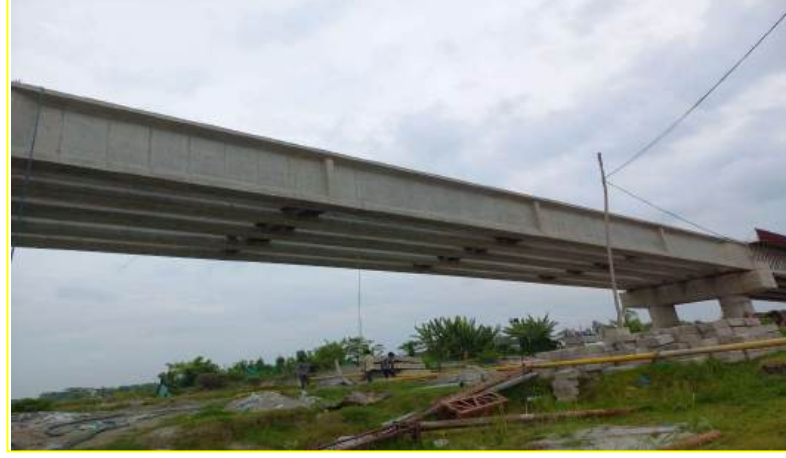
ঢাকার কেরানীগঞ্জ থেকে মুন্সীগঞ্জের হাসাড়া পর্যন্ত জেলা মহাসড়কে প্রকল্পের চলমান কাজ
