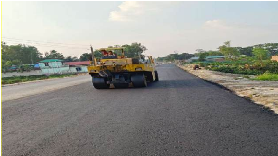
আরিচা (বরঞ্জাইল)-ঘিওর-দৌলতপুর-নাগরপুর-টাঙ্গাইল আঞ্চলিক মহাসড়কের পেভমেন্ট নির্মাণ কাজ
