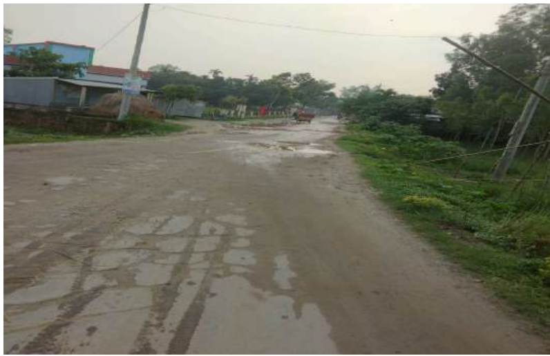
মাদারগঞ্জ-জামখল সড়ক (আর-৪৬৩) প্রশস্তকরণ ও মজবুতিকরণ প্রকল্পের চলমান কাজ
