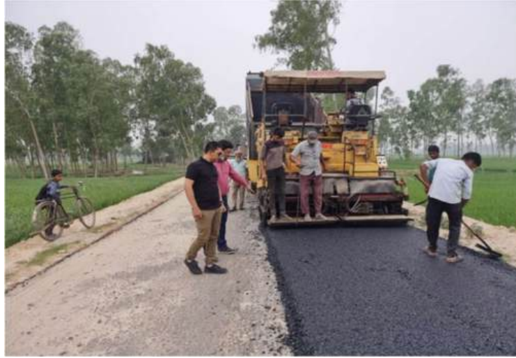
বামনডাঙ্গা (গাইবান্ধা)-শতিবাড়ী-আফতাবগঞ্জ (দিনাজপুর) জেলা মহাসড়কের চলমান কাজ
