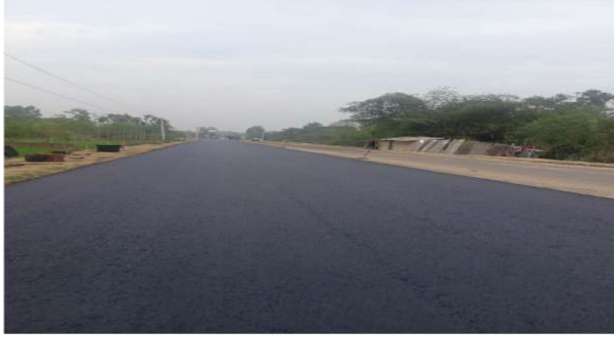
কক্সবাজার জেলার একতাবাজার হতে বানৌজা ঘাটি পর্যন্ত মহাসড়ক উন্নয়ন কাজ
