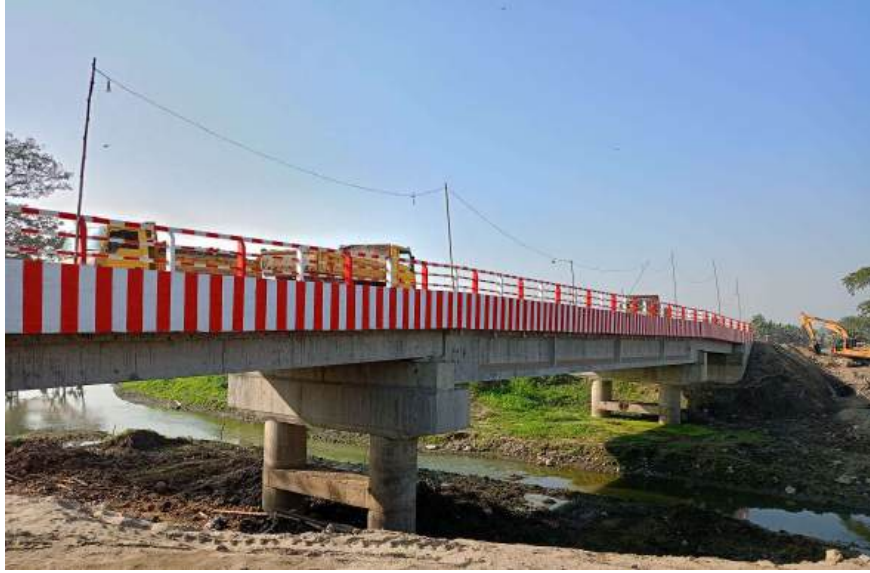
ভরাডোবা-সাগরদিঘী-ঘাটাইল-ভূঞাপুর (জেড-৩০৩৭) সড়কে নির্মিত বাজ্জা সেতু
