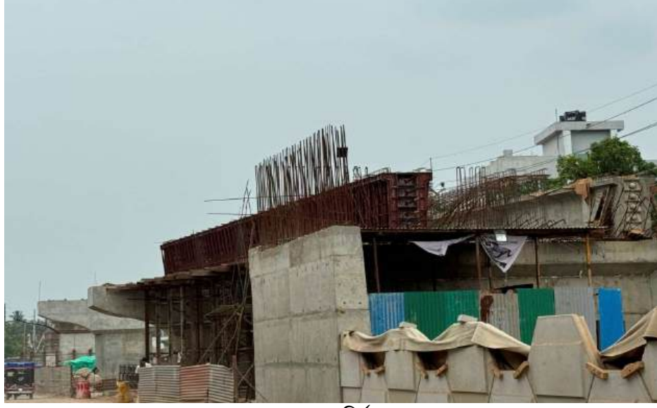
রেলবাজার রেলওয়ে ওভারপাস নির্মাণ প্রকল্পের চলমান কাজ
