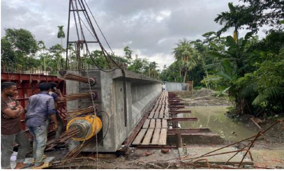
প্রকল্পের আওতায় পিসি গার্ডার সেতু ও আরসিসি বক্স কালভার্ট নির্মাণ প্রকল্পের চলমান কাজ
