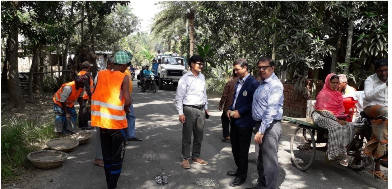
অতিরিক্ত সচিব, জনাব মোঃ এহছানে এলাহী কর্তৃক পুঠিয়া-আড়ানী-বাঘা জেলা সড়কের চলমান কাজ পরিদর্শন
