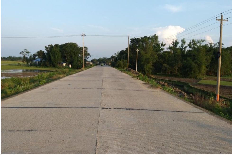
সিলেট বিমানবন্দর ইন্টারসেকশন-লালবাগ-কোম্পানিগঞ্জ-সালুটিকর-ভোলাগঞ্জ মহাসড়ক
