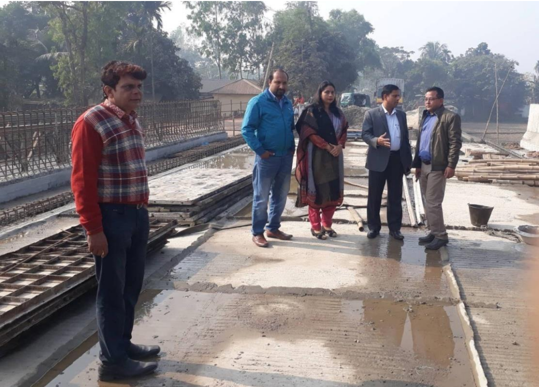
মনিটরিং টিম প্রধান জনাব ড. সৈয়দা সালমা বেগম কর্তৃক বগুড়া-সারিয়াকান্দি সড়কের ৩টি বেইলী সেতু (খেলসাকুড়ি, জয়ভোগা, হাট ফুলবাড়ী) প্রতিস্থাপন কাজ পরিদর্শন
