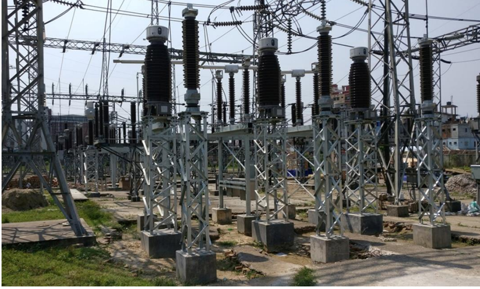
মানিকনগর গ্রিড সাব-স্টেশনে চলমান Bay নির্মাণ কাজ
