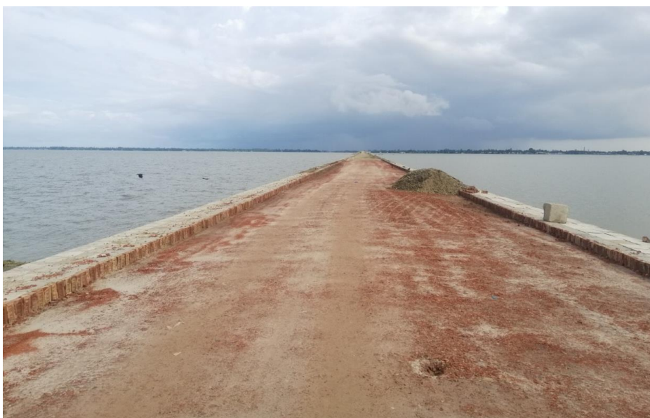
নির্মাণাধীন ইটনা-মিঠামইন-অষ্টগ্রাম মহাসড়ক
