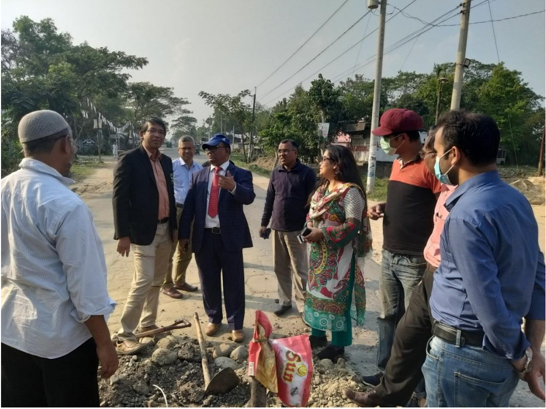
মনিটরিং টিম প্রধান জনাব জেসমিন নাহার কর্তৃক গোলাপগঞ্জ-চারখাই-জকিগঞ্জ মহাসড়কের উন্নয়ন কাজ পরিদর্শন
