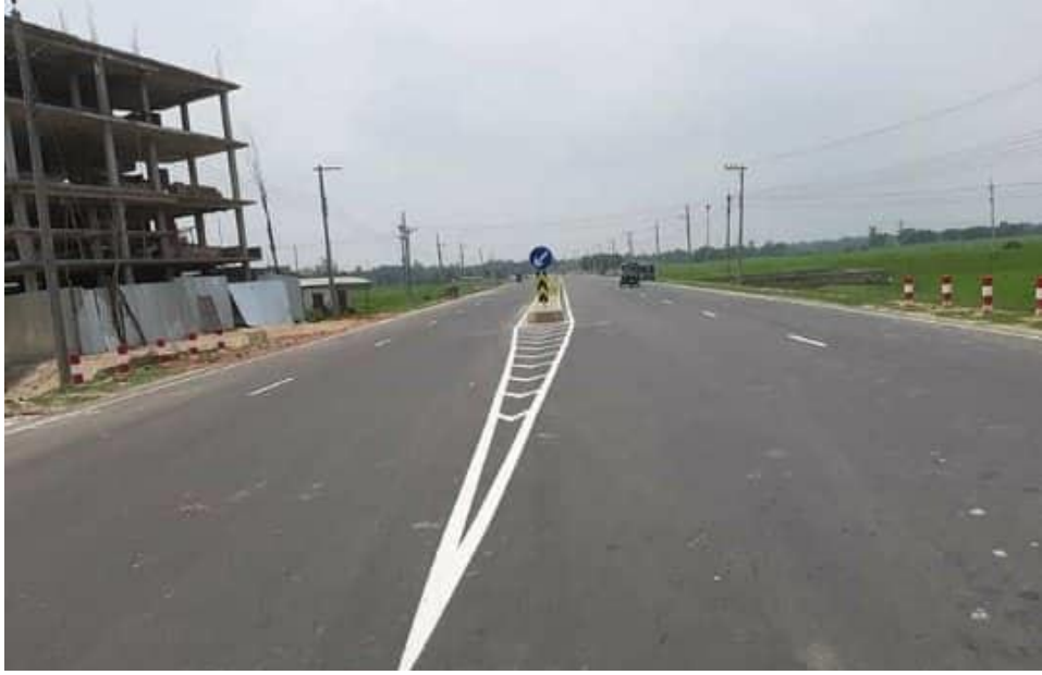
ঢাকা-চট্টগ্রাম-কক্সবাজার মহাসড়কের ইন্দ্রপুল থেকে চক্রশালা পর্যন্ত অংশের বাঁক সরলীকরণ প্রকল্পের আওতায় নির্মিত মহাসড়ক
