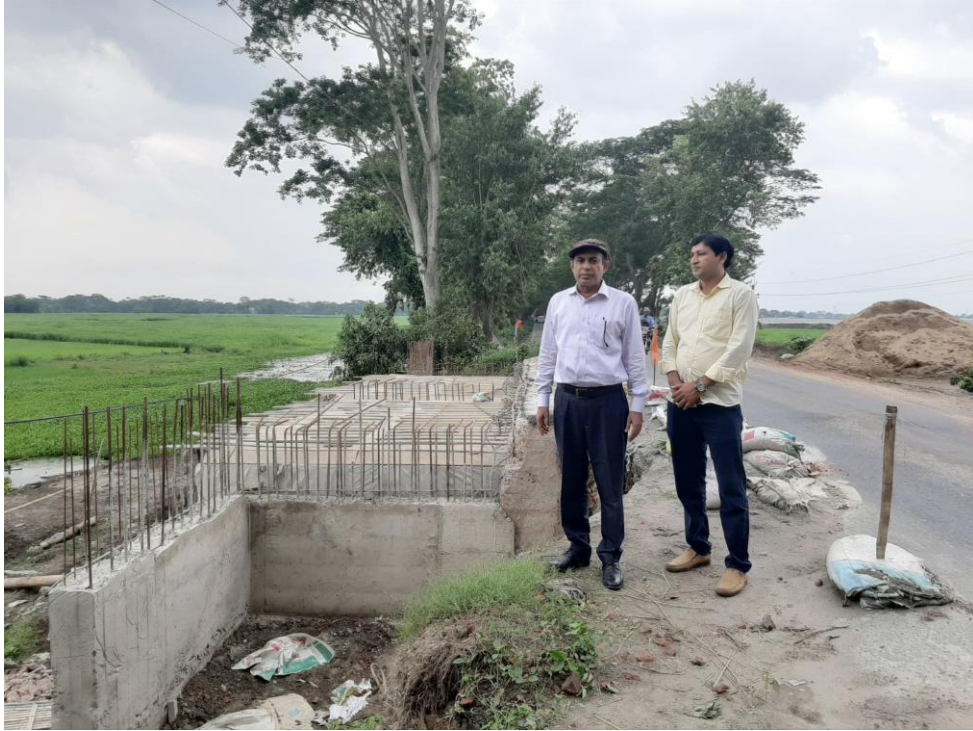
মনিটরিং টিম প্রধান জনাব মোঃ জাকির হোসেন কর্তৃক ঢাকা-মাওয়া-ভাঙ্গা-মোস্তফাপুর-বরিশাল জাতীয় মহাসড়কের উন্নয়ন কাজ পরিদর্শন
