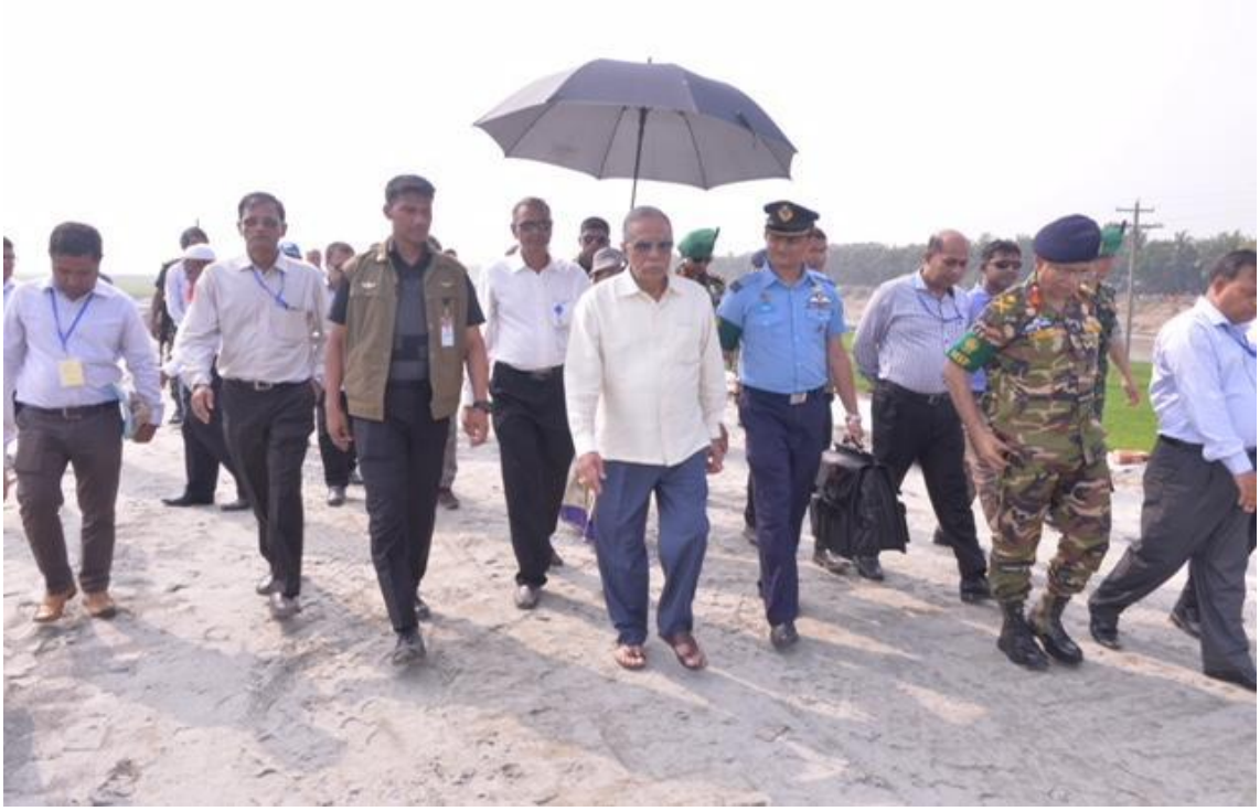
মহামান্য রাষ্ট্রপতি কর্তৃক নির্মাণাধীন ইটনা-মিঠামইন-অষ্টগ্রাম মহাসড়ক পরিদর্শন
