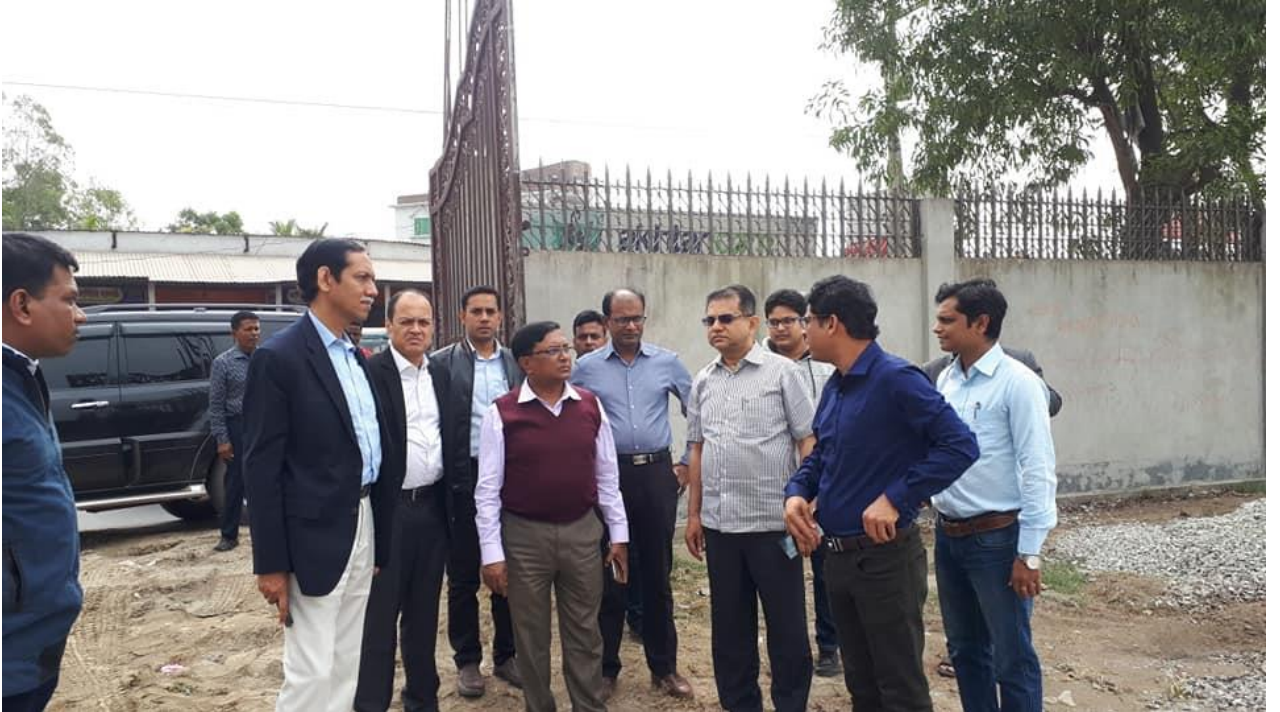
সচিব, জনাব মোঃ নজরুল ইসলাম কর্তৃক নারায়ণগঞ্জে মহাসড়কের নির্মাণ কাজ পরিদর্শন
