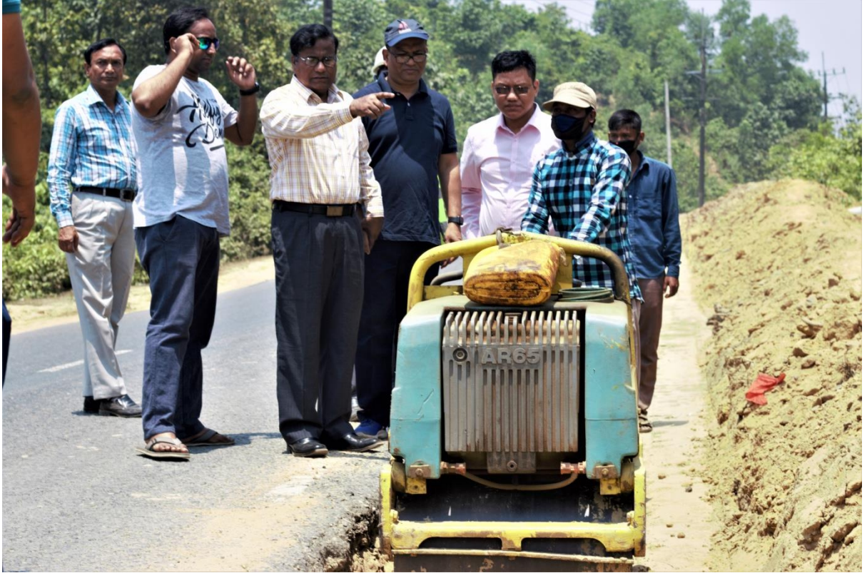
মনিটরিং টিম প্রধান জনাব মো: আবদুর রৌফ খান কর্তৃক কক্সবাজার-টেকনাফ মহাসড়কের উন্নয়ন প্রকল্প পরিদর্শন
