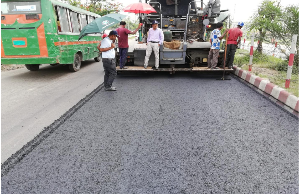
পিএমপি (সড়ক) এর আওতায় নবীনগর-ডিইপিজেড-চন্দ্রা মহাসড়কে চলমান সংস্কার কাজ
