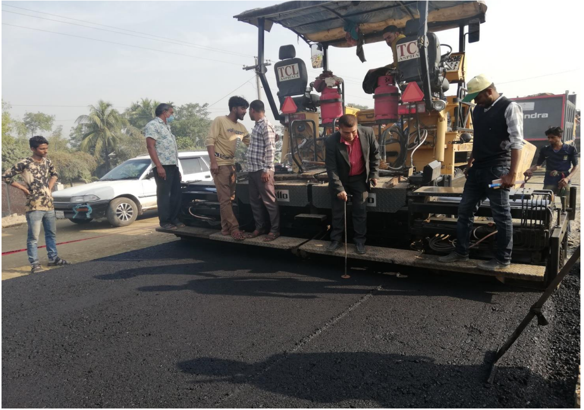
ময়মনসিংহ -নেত্রকোণা-মোহনগঞ্জ-জামালগঞ্জ-সুনামগঞ্জ মহাসড়কে চলমান উন্নয়ন কাজ
