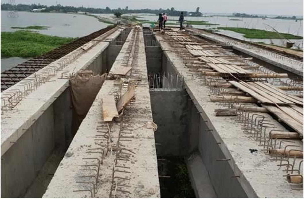
নবীনগর-শিবপুর-রাধিকা আঞ্চলিক মহাসড়ক নির্মাণ প্রকল্পের আওতায় নির্মাণাধীন কনিকাড়া সেতু
