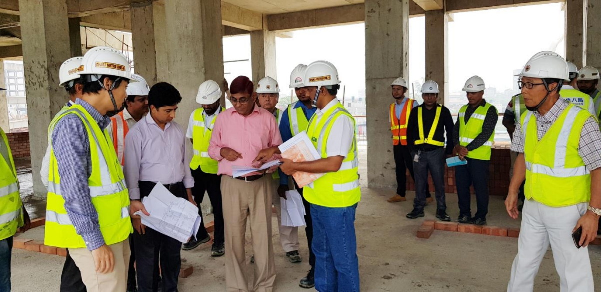
ব্যবস্থাপনা পরিচালক (ডিএমটিসিএল) কর্তৃক উত্তরা ডিপো এলাকার পূর্ত কাজ পরিদর্শন
