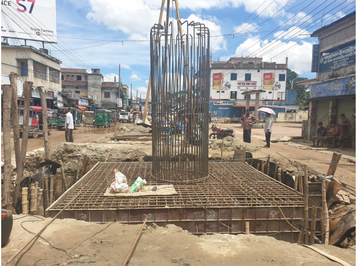
জামালপুর শহরের গেইটপাড় এলাকায় নির্মাণাধীন রেলওয়ে ওভারপাস
