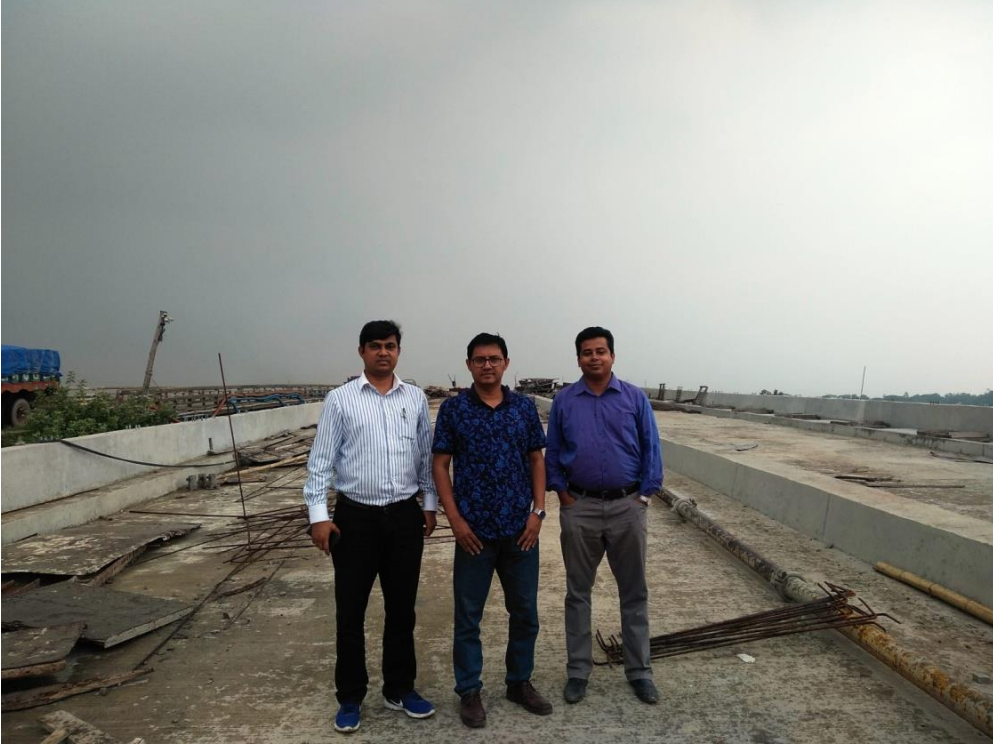
মনিটরিং টিম প্রধান জনাব মোহাম্মদ ফারুক হোসেন কর্তৃক ঢাকা (কাঁচপুর)-ভৈরব- জগদীশপুর-শায়েস্তাগঞ্জ-সিলেট-তামাবিল-জাফলং মহাসড়কে তিতাস নদীর ওপর শাহবাজপুর সেতুর নির্মাণ কাজ পরিদর্শন
