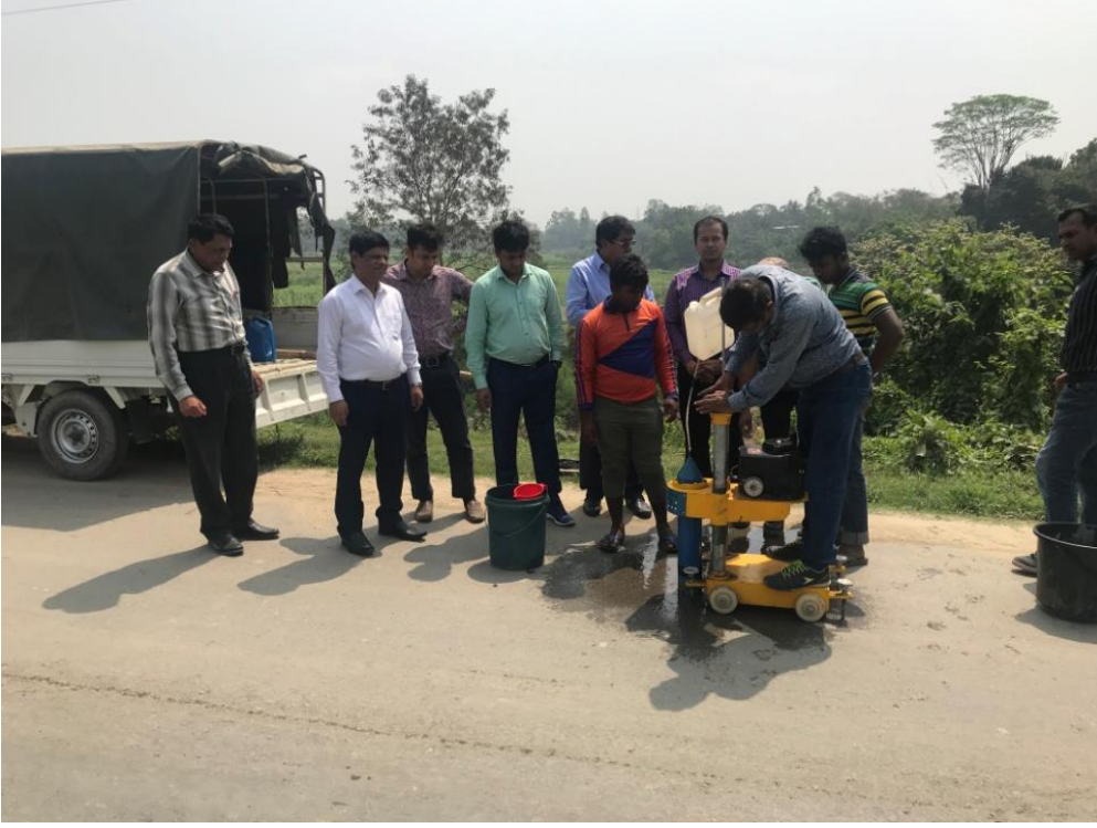
মনিটরিং টিম প্রধান জনাব মোঃ নজরুল ইসলাম সরকার কর্তৃক নয়াপুর-আড়াইহাজার-নরসিংদী-রায়পুরা মহাসড়কের চলমান কাজ পরিদর্শন
