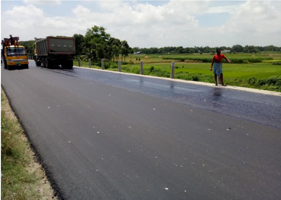
হেমায়েতপুর-সিংগাইর-মানিকগঞ্জ আঞ্চলিক মহাসড়কে চলমান উন্নয়ন কাজ
