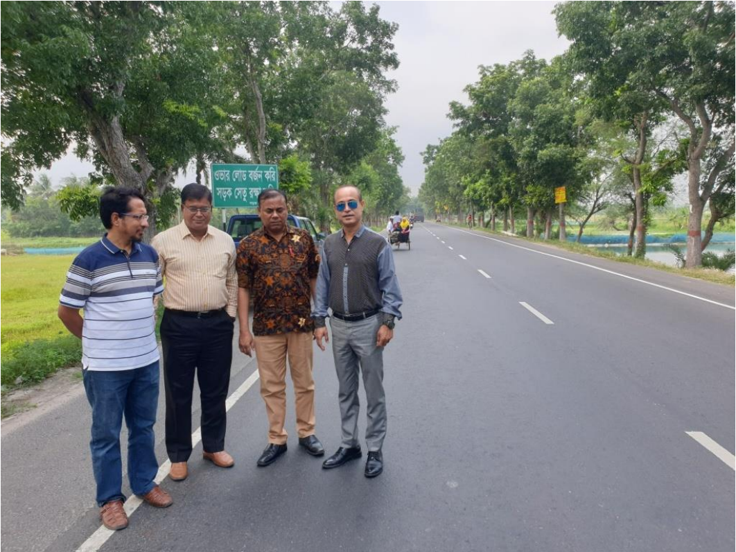
মনিটরিং টিম প্রধান জনাব মোঃ সামীমুজ্জামান কর্তৃক নওয়াপাড়া-বাগেরহাট-পিরোজপুর আঞ্চলিক মহাসড়কে পিসি গার্ডার সেতুর নির্মাণ কাজ পরিদর্শন
