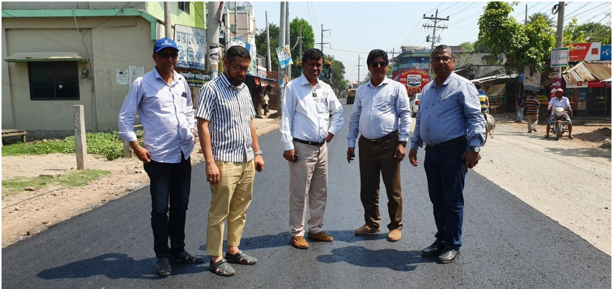
মনিটরিং টিম প্রধান জনাব মনীন্দ্র কিশোর মজুমদার কর্তৃক যশোর-খুলনা মহাসড়কের নির্মাণ কাজ পরিদর্শন
