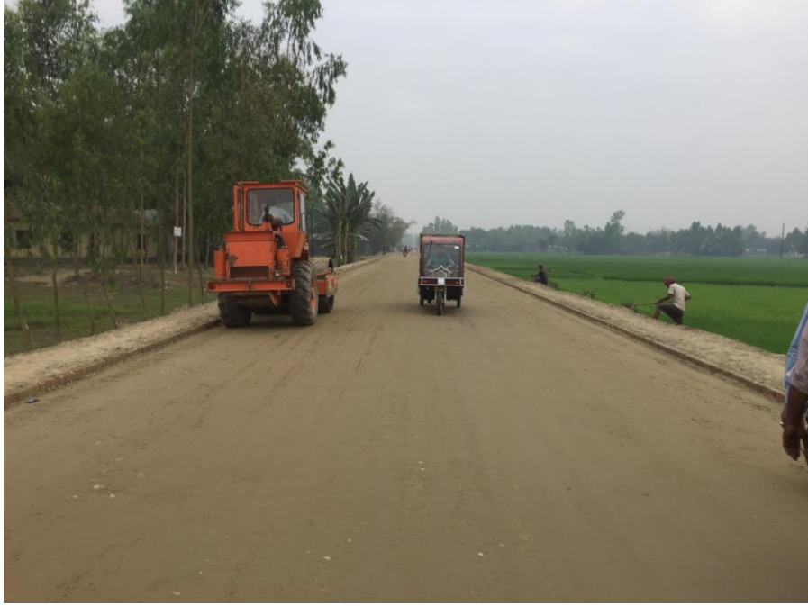
জামালপুর-খানুয়া কামালপুর-কদমতলা (রৌমারী) মহাসড়কের চলমান কাজ
