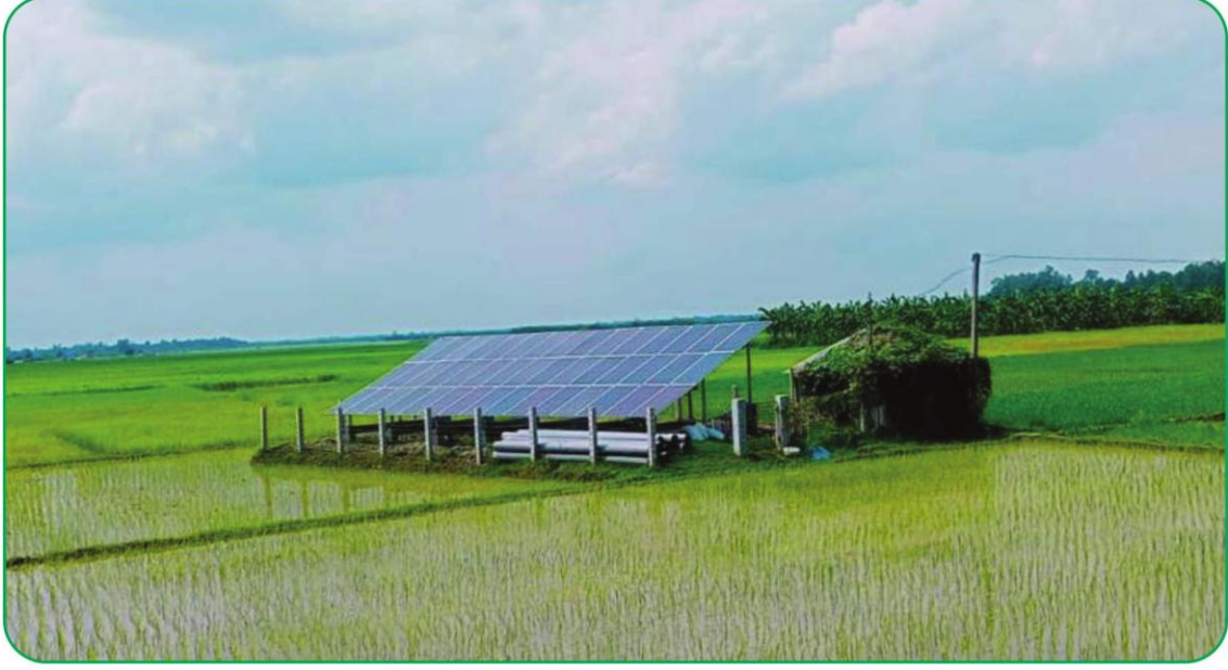
নাটোর পবিস-২ এ স্থাপিত ৭.৫ কিলোওয়াট সোলার পাম্প
