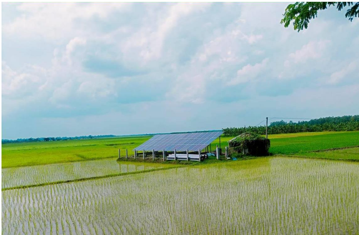
নাটোর পবিস-২ এ স্থাপিত ৭.৫ কিলোওয়াট সোলার পাম্প
