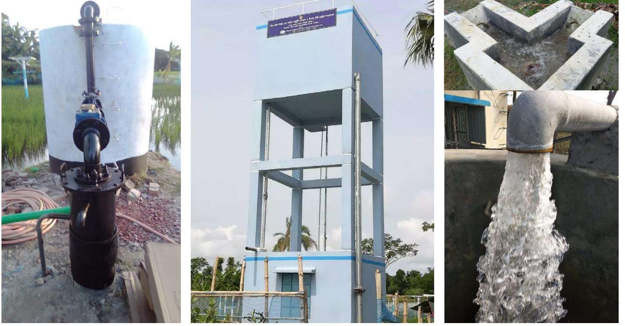
“সৌর শক্তি নির্ভর সেচ প্রকল্পের মাধ্যমে স্থাপিত নলকূপের পানি সেচের পাশাপাশি গৃহস্থালী কাজে ব্যবহার”
