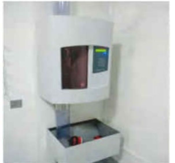
চিত্র-১২ (২) : Pneumatic Sample Transport (PST) System এর মাধ্যমে নমুনা গ্রহণ
