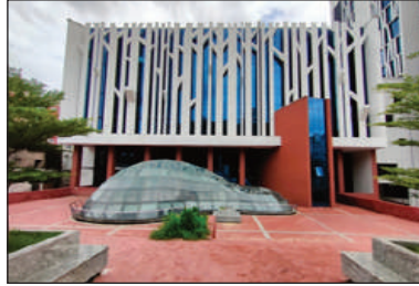
নবনির্মিত চট্টগ্রাম মুসলিম ইনস্টিটিউট ভবন
