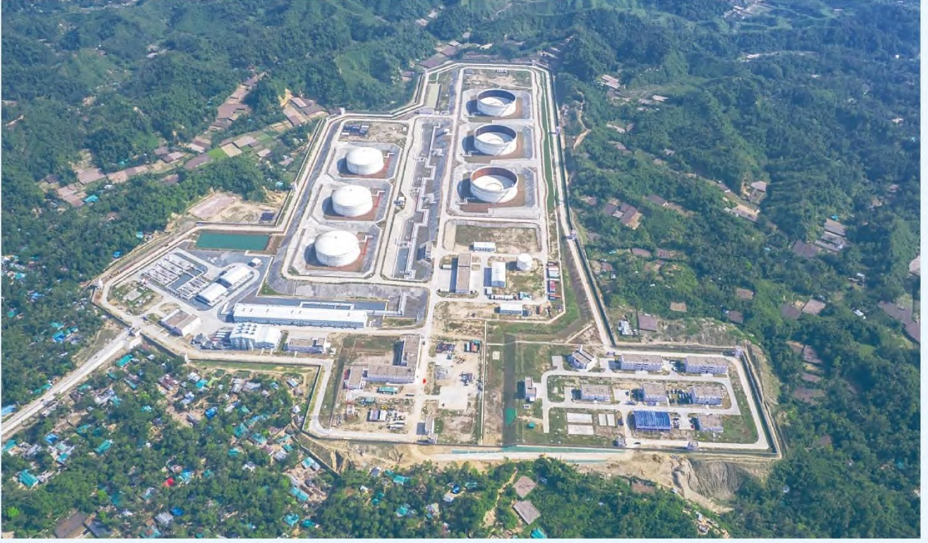
পিএসটিএফ স্থাপনা, মহেশখালী, কক্সবাজার
