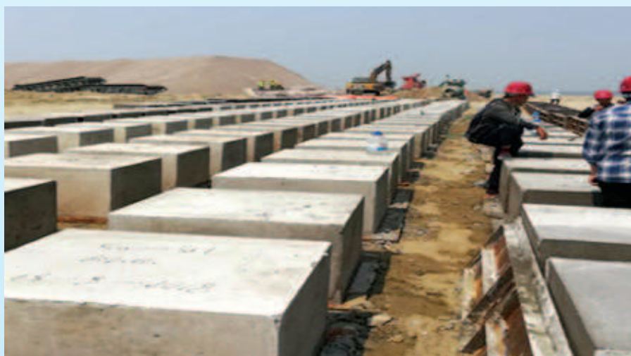
চিত্র: প্রকল্প এলাকায় বাঁধের ঢাল সংরক্ষণের জন্য সিসি ব্লক তৈরী
