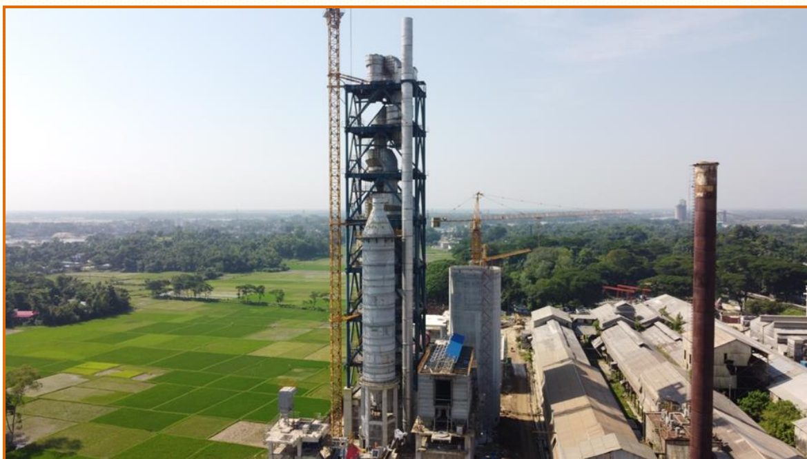
চিত্রঃ ছাতক সিমেন্ট কোম্পানী লি: (Pre-Heater এর মেকানিক্যাল ইনস্টলেশন কাজ চলমান)
