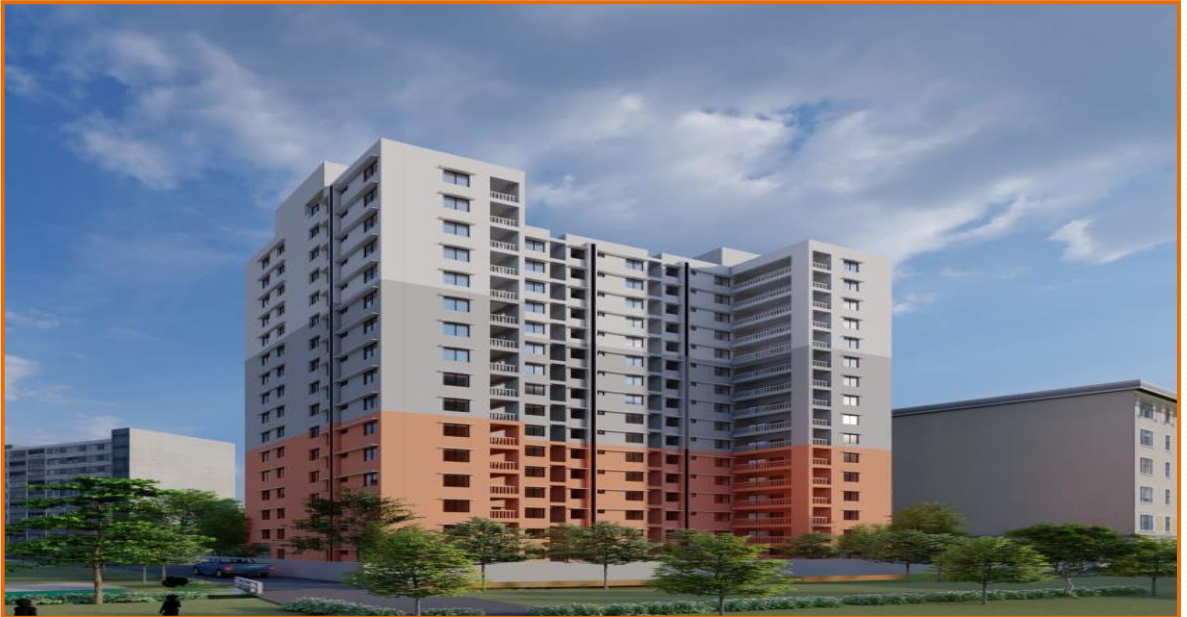
চিত্র: চট্টগ্রাম সিটি কর্পোরেশনের আওতাধীন পরিচ্ছন্নকর্মী নিবাস নির্মাণ।
