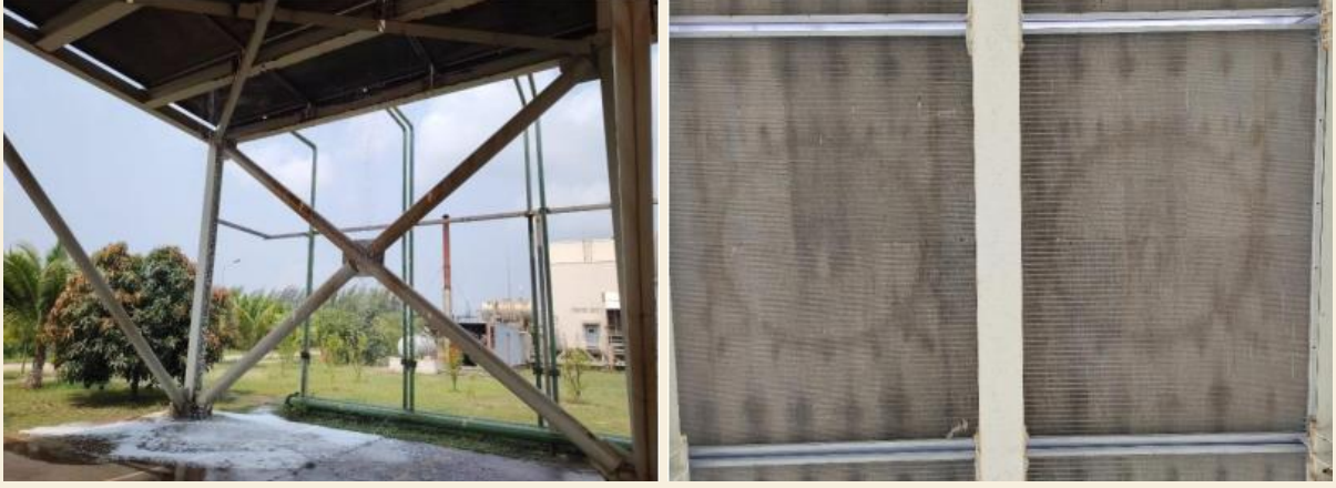
চিত্রঃ Liquid detergent ও পানি দিয়ে পরিষ্কার করার পরের অবস্থা
