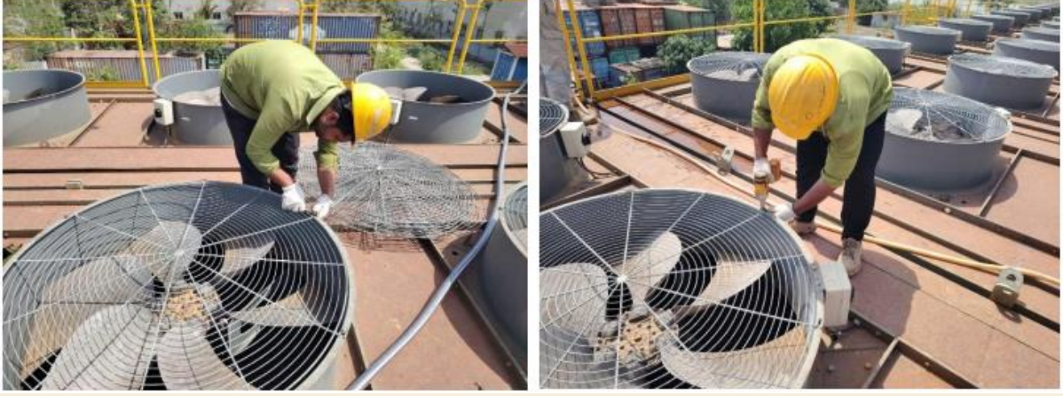
চিত্রঃ Radiator এর safety guard খোলা হচ্ছে
