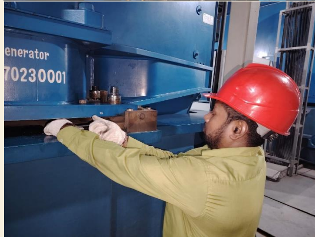
চিত্রঃ Flexible coupling alignment চেক করা হচ্ছে
