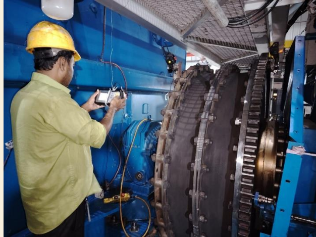
চিত্রঃ Crankshaft hot deflection measure করা হচ্ছে
