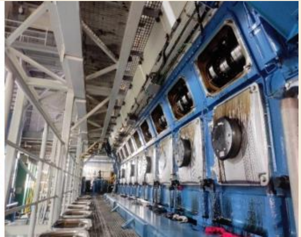
চিত্রঃ Camshaft contact faces inspection করা হচ্ছে
