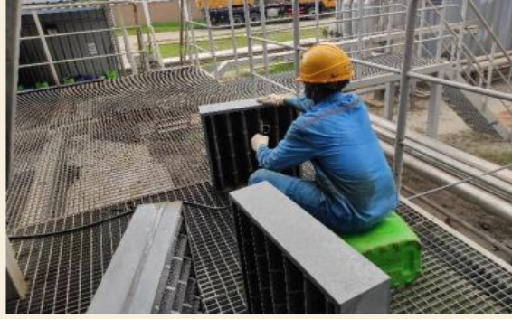
চিত্রঃ চার্জ এয়ার ফিল্টার গুলো বাতাস দিয়ে পরিষ্কার করা হচ্ছে
