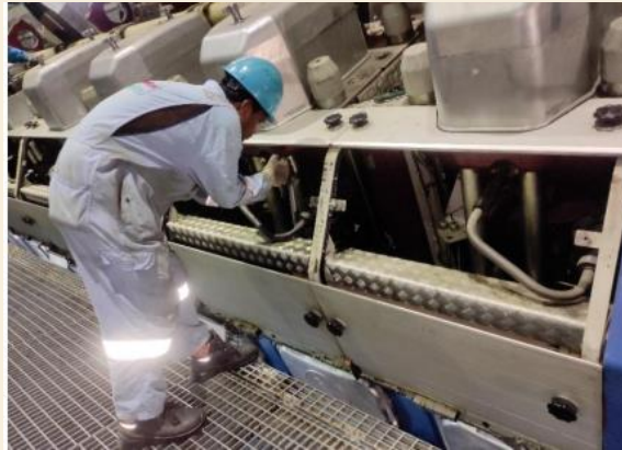
চিত্রঃ Fuel rack এ লুব্রিকেশন করা হচ্ছে
