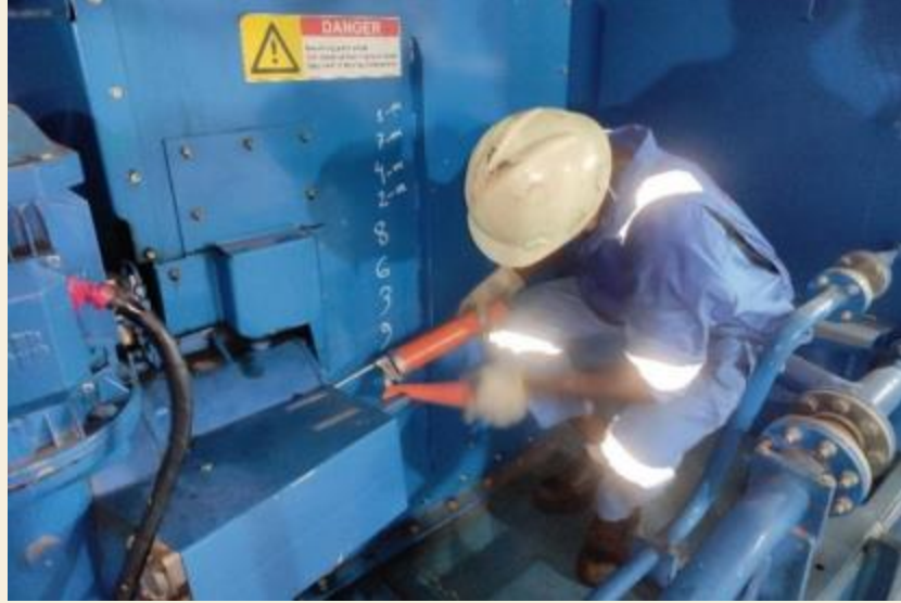
চিত্রঃ Turning gear's secondary shaft এ greasing করা হচ্ছে
