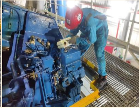
চিত্রঃ Actuator এর used oil বের করে নতুন oil দেওয়া হচ্ছে
