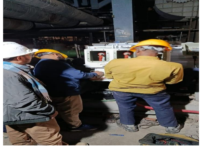
চিত্র-৪ : OTM পদ্ধতিতে ক্রয়কৃত নতুন CCW Pump Motor-B (6.6KV, 300KW)-এর স্থাপন (Installation) কার্যক্রম
