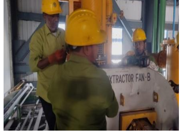
চিত্র-৩.১ : এসিড ডোজিং সিস্টেমের Ejector Fabrication work. চিত্র-৩.২ : GT Lube Oil System এর Vapor Extractor Fan-B এর মেরামত কার্যক্রম।
