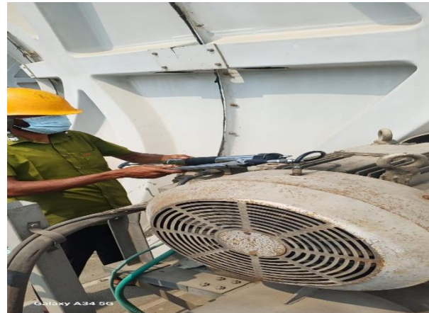
চিত্র-৬: Cooling Tower Fan Motor-8-এর বার্ষিক রক্ষণাবেক্ষণ কার্যক্রম।
