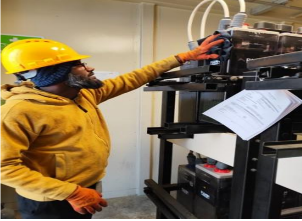
চিত্র-৫ : GT Control Package-এর Battery সমূহের নির্ভরযোগ্য কার্যকারিতা নিশ্চিত করার জন্য বার্ষিক রক্ষণাবেক্ষণ কার্যক্রম।
