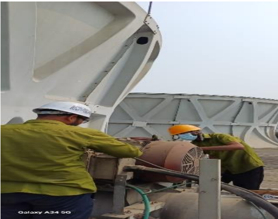
চিত্র-৬: Cooling Tower Fan Motor-8-এর বার্ষিক রক্ষণাবেক্ষণ কার্যক্রম।
