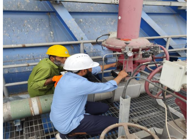
চিত্র-৮.২ : HRSG IP Control Valve-2 এর Actuator এর Hunting ত্রুটি সারানো হচ্ছে।
