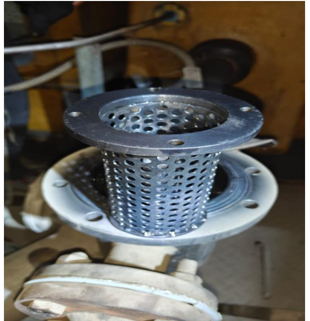
চিত্র ১.২.২: স্ট্রেইনার পরিষ্কারের পরের অবস্থা।
