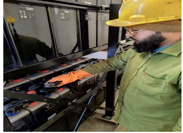
চিত্র-৫ : GT Control Package-এর Battery সমূহের নির্ভরযোগ্য কার্যকারিতা নিশ্চিত করার জন্য বার্ষিক রক্ষণাবেক্ষণ কার্যক্রম।
