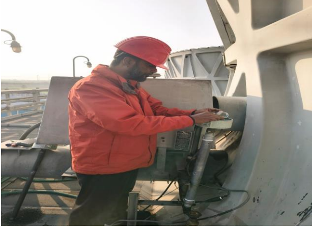
চিত্র-৭.১ : Cooling Tower Fan-4 এর Lube Oil Limit Switch পরিবর্তন করা হচ্ছে।
