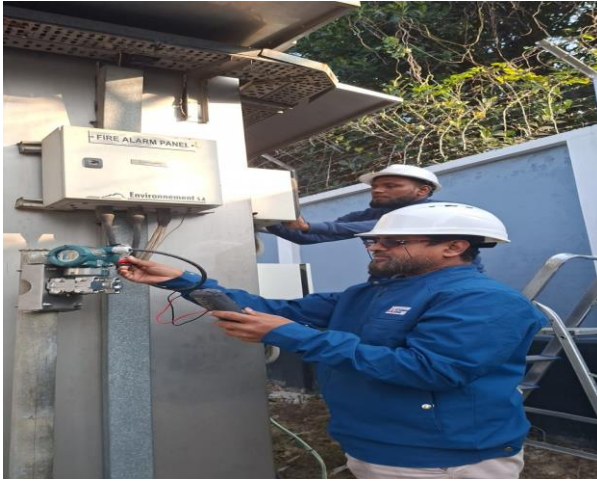
চিত্র-৮.১ : Ambient Pressure transmitter স্থাপন করা হয়েছে।
