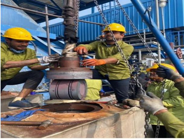
চিত্র ১.১: মেরামত কাজের জন্য HP Control Valve-01 & 02 এর Isolation valve উত্তোলনের।
