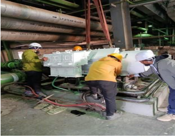
চিত্র-৪ : OTM পদ্ধতিতে ক্রয়কৃত নতুন CCW Pump Motor-B (6.6KV, 300KW)-এর স্থাপন (Installation) কার্যক্রম
