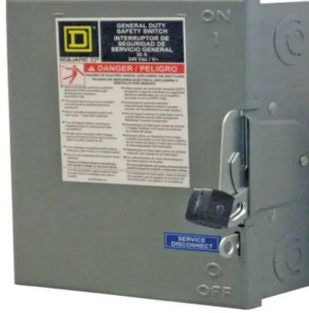
চিত্র ৭: একটি বাহ্যিকভাবে পরিচালিত (EXO) প্রধান সংযোগ বিচ্ছিন্ন
