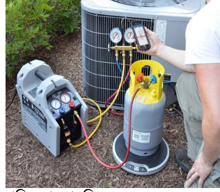
চিত্র: রেফ্রিজারেন্ট রিকভারি করার পদ্ধতি
