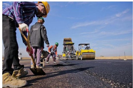
রোডওয়ার্ক বা রোড কন্সট্রাকশন
