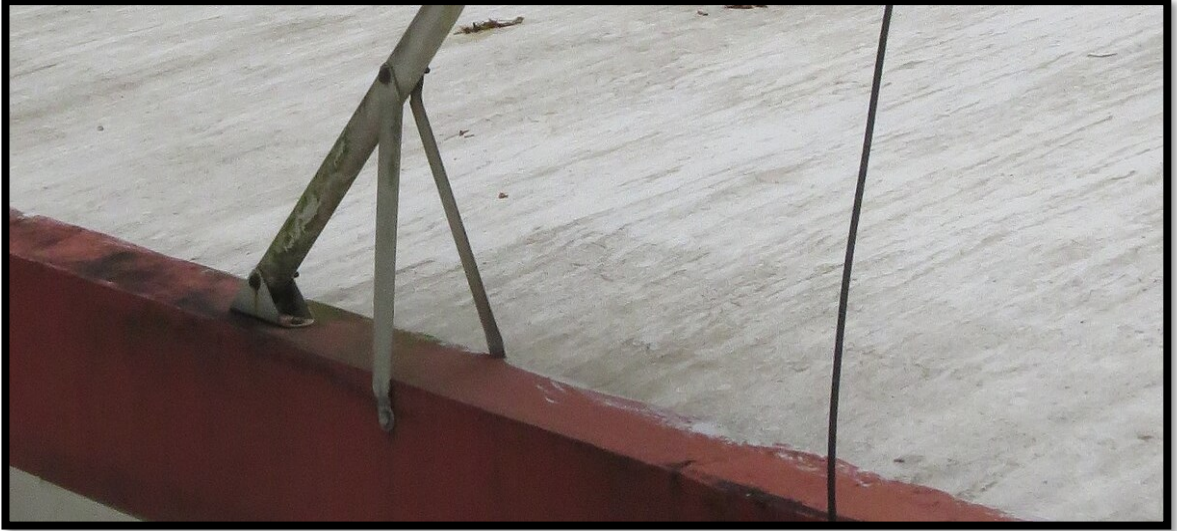
চিত্র: সাইট পরিদর্শন
