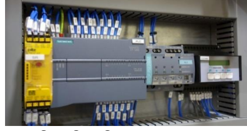
চিত্র : পিএলসি সরবরাহ পাওয়ার চেক করা
