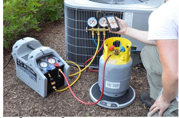
চিত্র: রেফ্রিজারেন্ট রিকভারি করার পদ্ধতি
