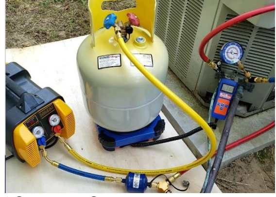
চিত্র: রেফ্রিজারেন্ট রিসাইক্লিং করার পদ্ধতি
