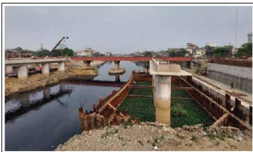
চিত্র: টঙ্গী নদীতে অতি স্বল্প উচ্চতার স্বল্প দৈর্ঘ্যের ব্রীজ এবং রেলসেতু নির্মাণ করা হচ্ছে। নদীর জায়গা দখল করে ব্রীজ এর পিয়ার এবং এপ্রোন নির্মাণ করায় নদী অনেকটা সংকুচিত হয়ে গেছে।
