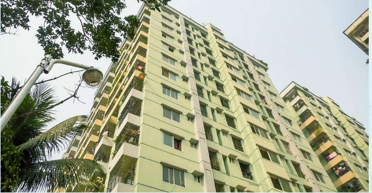
চিত্র: ঢাকার মিরপুরস্থ ১৫নং সেকশনে ১০০টি আবাসিক ফ্ল্যাট নির্মাণ প্রকল্পে প্রতিটি ফ্ল্যাটের আয়তন ১৫০০ বর্গফুট।
