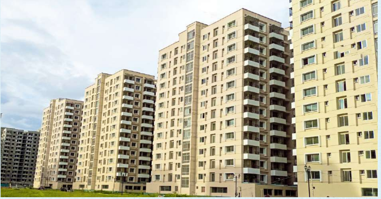
চিত্র: ঢাকার মিরপুরস্থ ৯নং সেকশনে স্বপ্ননগর-১ আবাসিক ফ্ল্যাট প্রকল্পের একাংশ।
