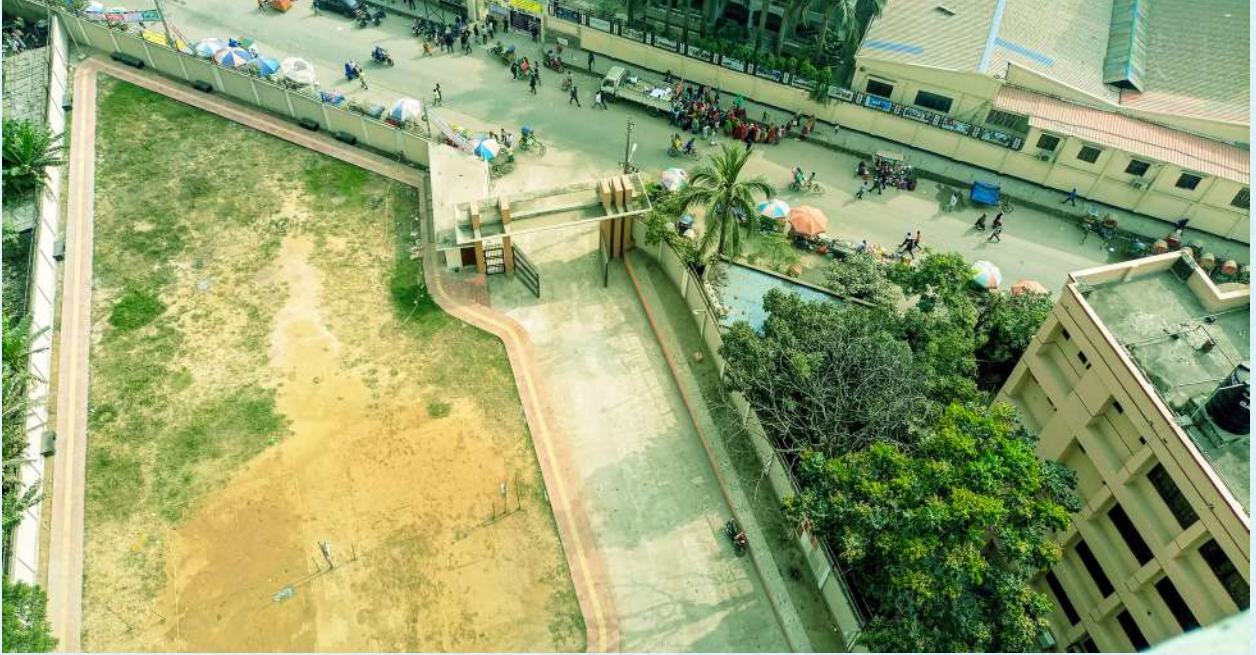
চিত্র: ঢাকার মিরপুরস্থ ১৫নং সেকশনে ১০০টি আবাসিক ফ্ল্যাট নির্মাণ।
