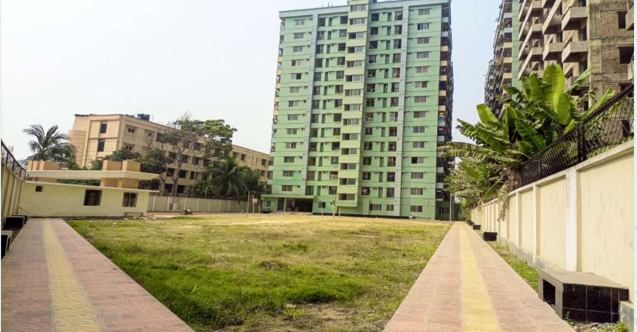
চিত্র: ঢাকার মিরপুরস্থ ১৫নং সেকশনে ১০০টি আবাসিক ফ্ল্যাট নির্মাণ প্রকল্প।
