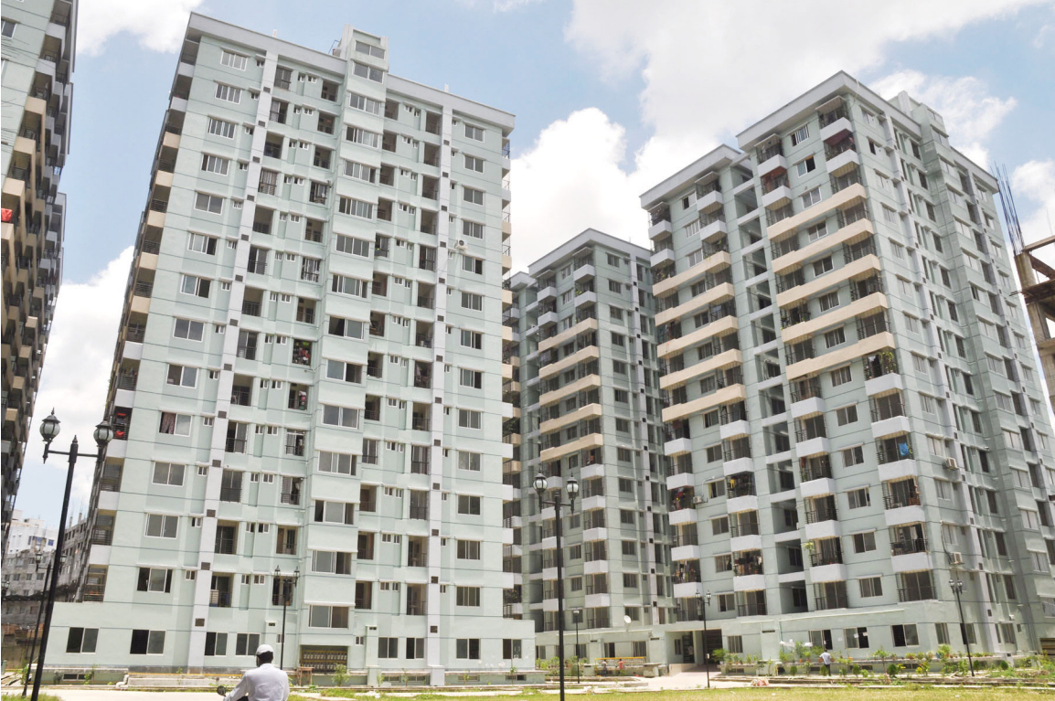
চিত্রঃ ঢাকার মিরপুর-১৫ সেকশনে সরকারী/ আধা-সরকারী কর্মকর্তাদের জন্য “জয়নগর” ৫২০টি আবাসিক ফ্ল্যাট নির্মাণ প্রকল্প।
