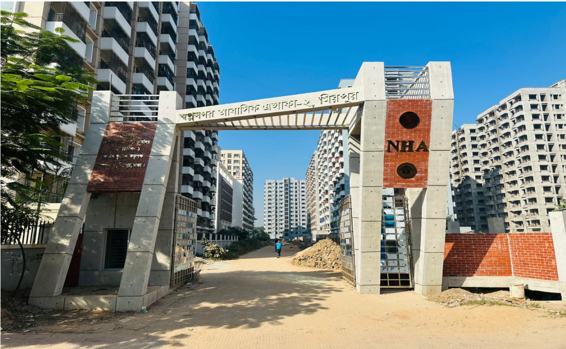
চিত্রঃ ঢাকার মিরপুরস্থ ৯ নং সেকশনে স্বল্প ও মধ্যম আয়ের লোকদের জন্য ১৫টি ১৪তলা বিশিষ্ট আবাসিক ফ্ল্যাট নির্মাণ (স্বপ্ননগর -২) প্রকল্প।
