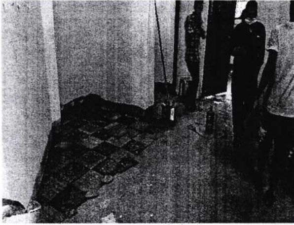
নিচতলা করিডোরের সৌন্দর্যবর্ধনের কাজ চলছে
