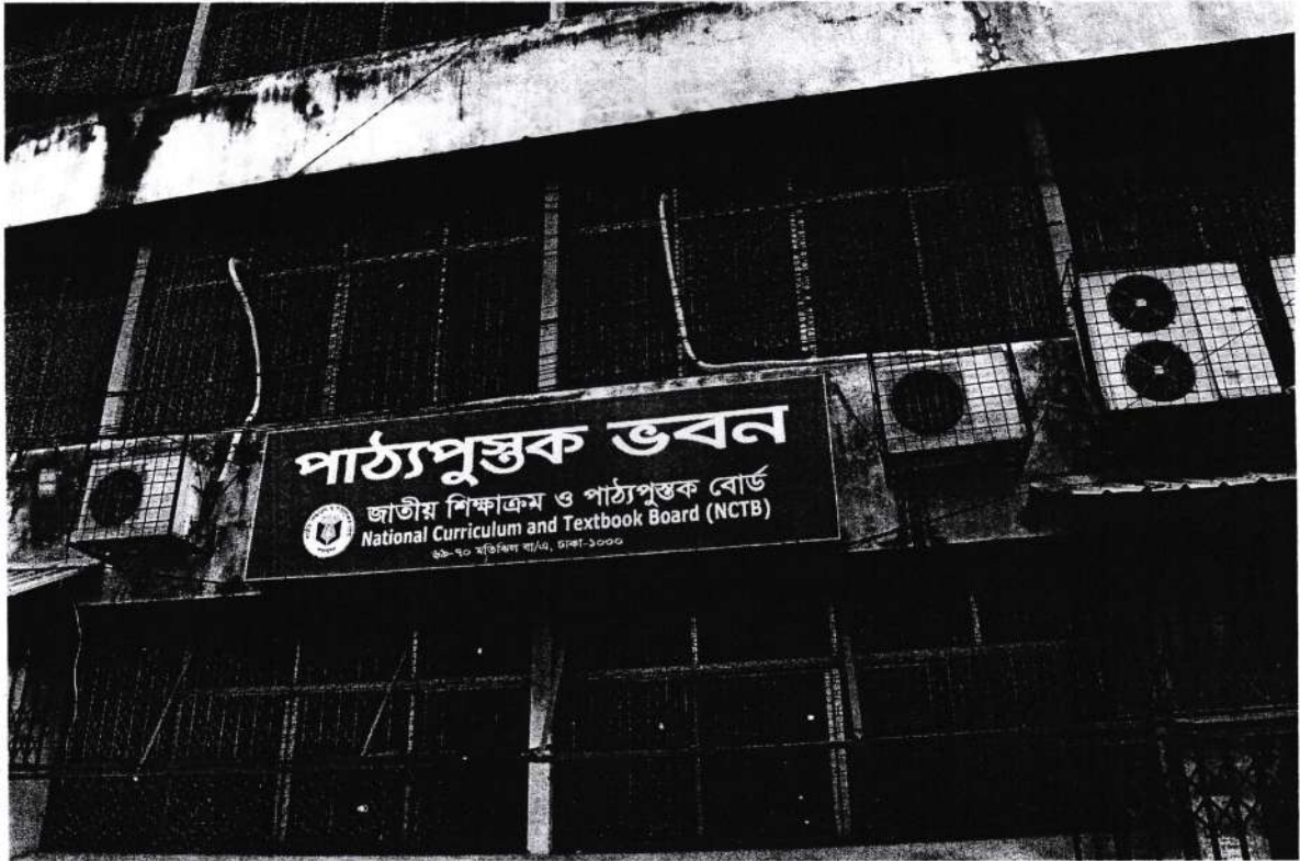
ভবনের পিছনে সাইনবোর্ড স্থাপন করা হয়েছে
