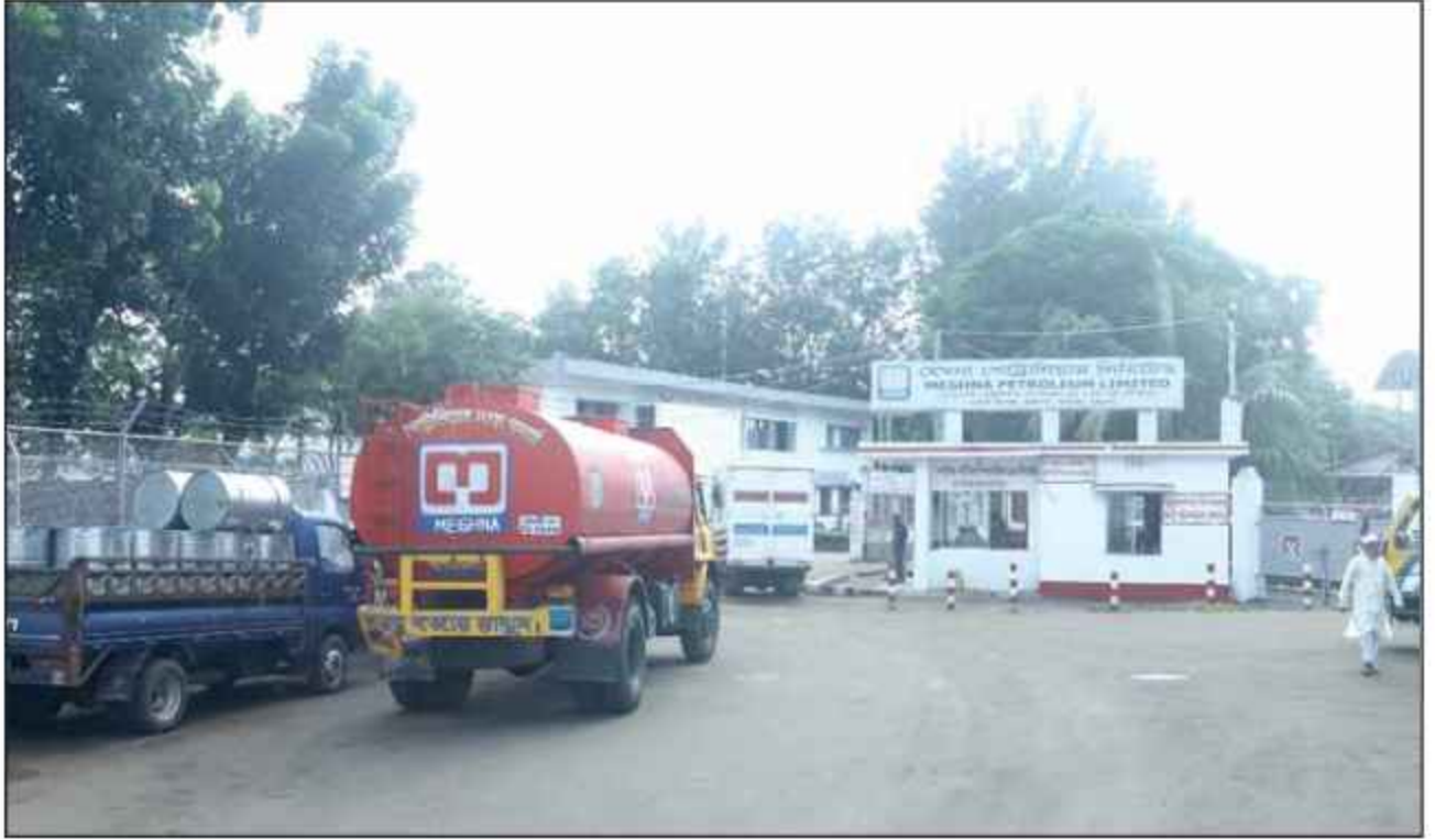
চট্টগ্রামের পতেঙ্গায় অবস্থিত কোম্পানির প্রধান স্থাপনা।
