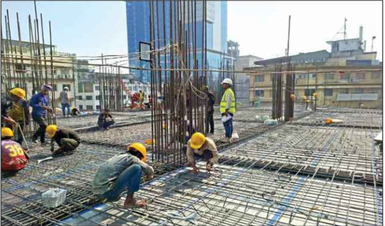
চট্টগ্রামের আত্মবাদস্থ ৭২নং প্লটে ৯তলা বিশিষ্ট প্রধান কার্যালয় ভবন নির্মাণ কার্যক্রম।
