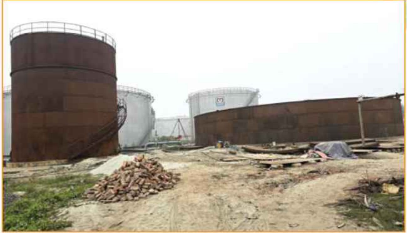
কোম্পানির গোদনাইল ডিপোতে ১টি ১০,০০০ হাজার মেট্রিক টন এবং অপরটি ১,০০০ হাজার মেট্রিক টন ধারণ ক্ষমতা সম্পন্ন দুইটি ট্যাংক নির্মাণ কাজের একাংশ।
