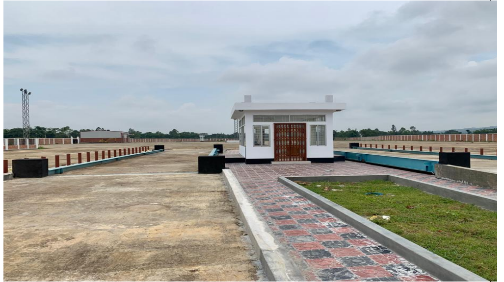
চিত্র ১৪: গোবড়াকুড়া-কড়ইতলী স্থলবন্দরের উন্নয়ন কার্যক্রম
