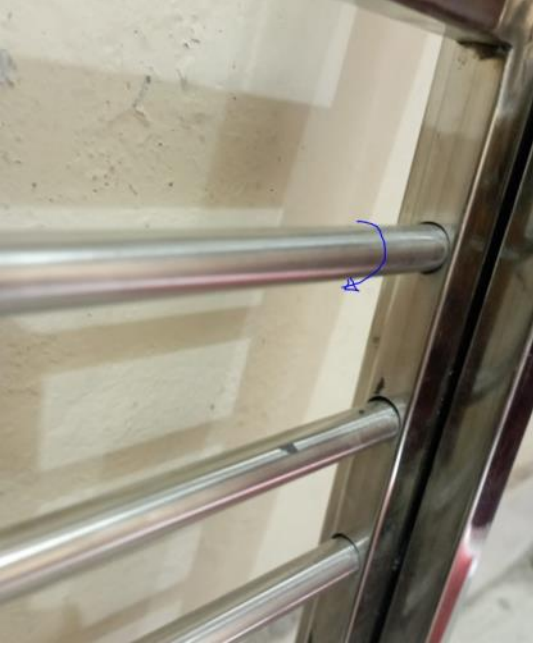
চিত্র ১০: ঘূর্ণনক্ষম রড যা নিষ্কিপ্ত পাথরের গতি হ্রাস করে এবং পাথরকে সুইং করিয়ে নিম্নমুখী করে
