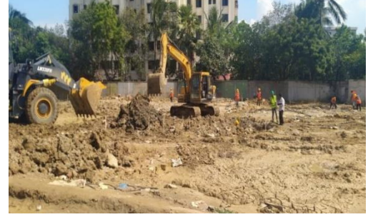
ফাউন্ডেশনে মাটিকাটা (আবাসিক ভবন)
