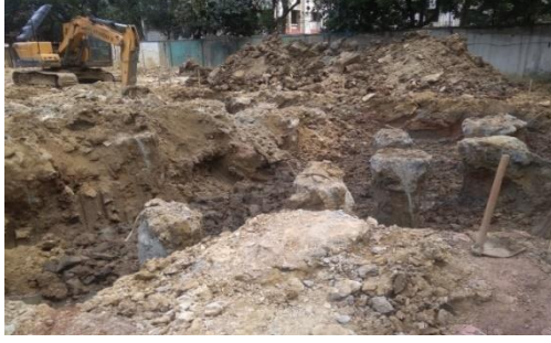
ফাউন্ডেশনে মাটিকাটা (আবাসিক ভবন)
