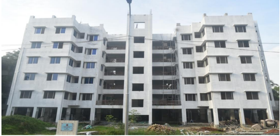
এমওডিসি সদর দপ্তর ও সেন্টার এন্ড রেকর্ডস এর ওআর'স পারিবারিক বাসস্থান (১৫ তলার ভিতসহ ৬তলা) এর ৩য় পর্যায়ের নির্মাণ কাজ চলমান
