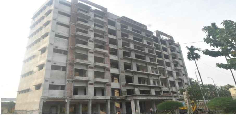
এমওডিসি সদর দপ্তর ও সেন্টার এন্ড রেকর্ডস এর এসএম ব্যারাক (৮ম তলার ভিতসহ ৮ম তলা) এর ৩য় পর্যায়ের নির্মাণ কাজ চলমান
