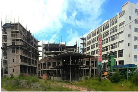
নির্মাণাধীন একাডেমিক ভবন
