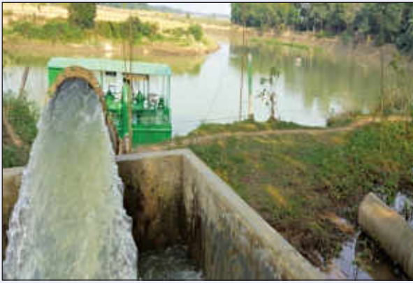
বিএডিসি'র ডাবল লিফটিং সেচ প্রকল্পের আওতায় স্থাপিত ভাসমান পাম্প
