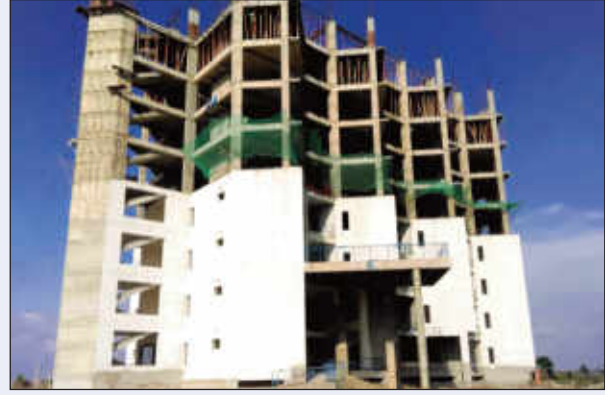
নির্মাণাধীন ১০-তলা অফিস ভবন, বারটান সদর দপ্তর, আড়াইহাজার
