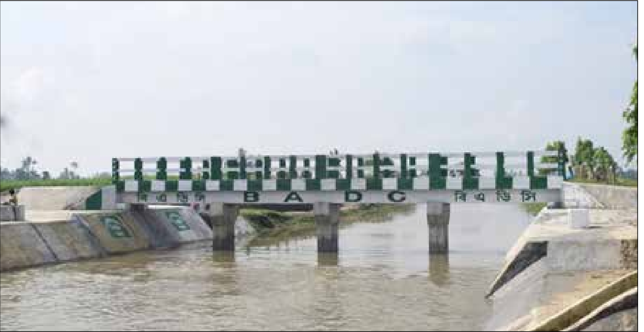
বৃহত্তর বগুড়া ও দিনাজপুর জেলা ক্ষুদ্রসেচ উন্নয়ন প্রকল্পের আওতায় বগুড়ার গাবতলীতে অবস্থিত সোনাই খালের ওপর নির্মিত হাইড্রোলিক স্ট্রাকচার
