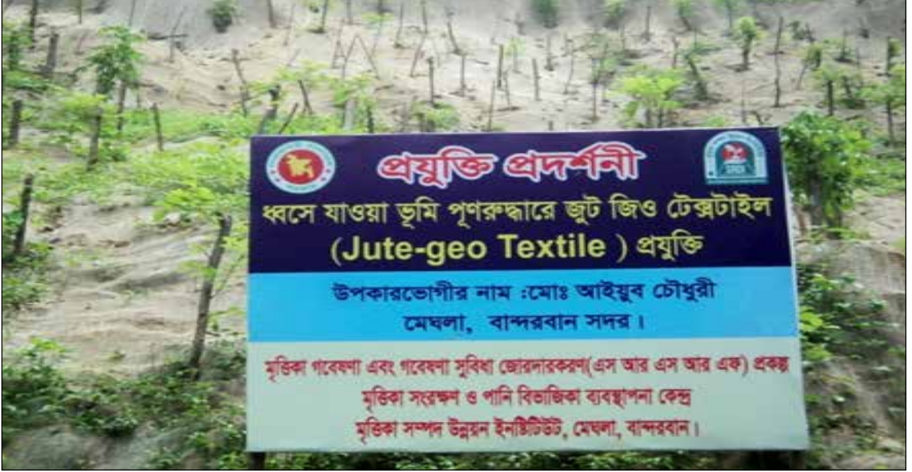
পাহাড়ি এলাকায় ধসে যাওয়া ভূমি পুনরুদ্ধারে জুট জিও টেক্সটাইল (Jute-geo textile) প্রযুক্তি
