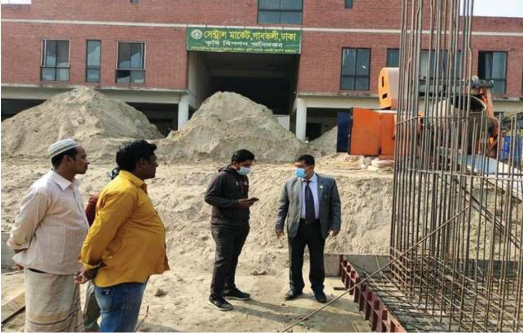
ঢাকার গাবতলীতে নির্মিতব্য ফুলের পাইকারি বাজার নির্মাণ কাজ পরিদর্শন করছেন জনাব আঃ গাফ্ফার খান, মহাপরিচালক, কৃষি বিপণন অধিদপ্তর।
