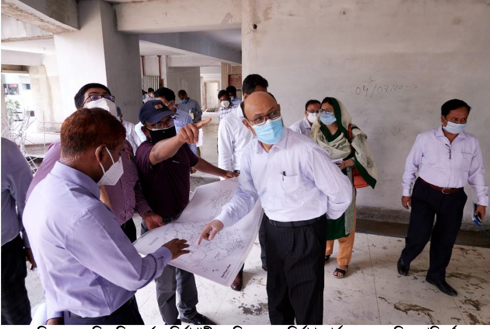
ছবি ৪.২১: ভূমি সচিব কর্তৃক নির্মাণাধীন ভূমি ভবনের নির্মাণ কার্যক্রম সরেজমিনে পরিদর্শন
