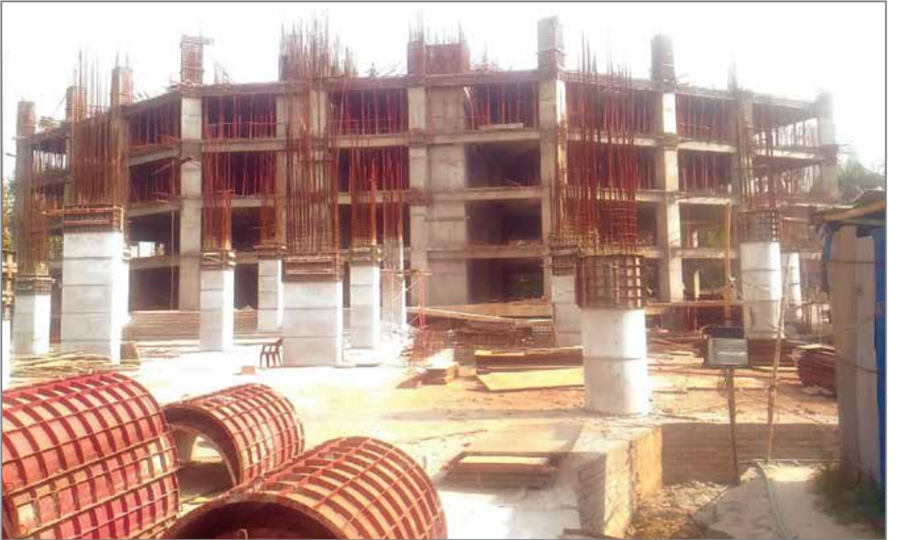
নির্মাণাধীন ভূমি ভবন কমপ্লেক্স (১৯ নভেম্বর ২০১৮)
