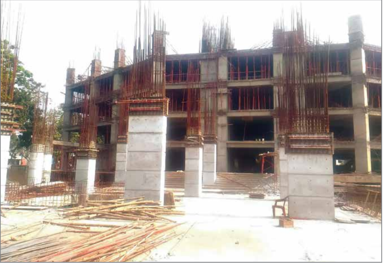
নির্মাণাধীন ভূমি ভবন কমপ্লেক্স (১৯ নভেম্বর ২০১৮)
