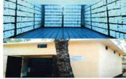
রেকর্ডরুমের নথি ও ভবনের পরের অবস্থা
