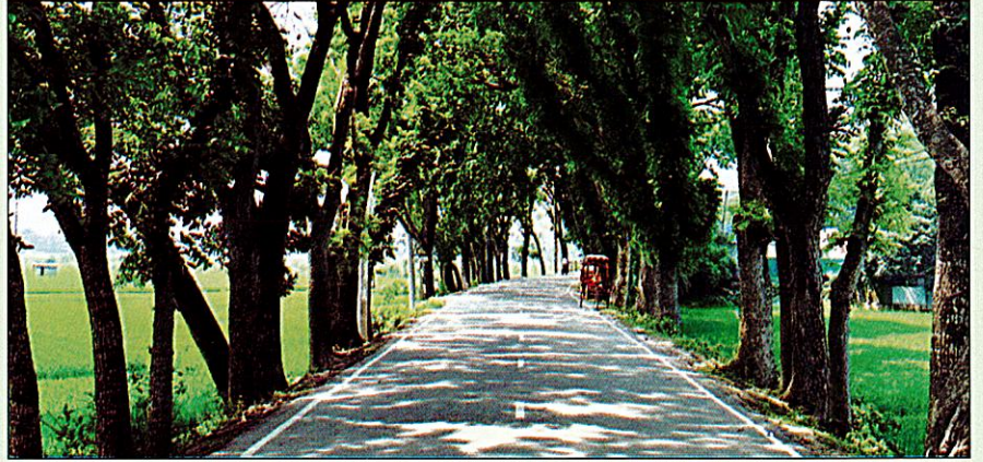
রক্ষণাবেক্ষণকৃত এলজিইডি মোড়-আয়নাপুর জিসি সড়ক, উপজেলা সদর, টাঙ্গাইল
