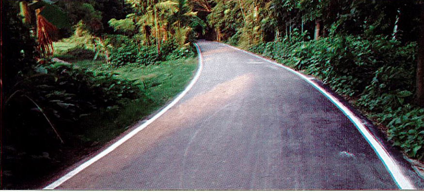
নবনির্মিত শরীয়তপুর জেলার গোসাইরহাট উপজেলার নাগেরপাড়া জিসি (দগুরি বাড়ি) থেকে খাসেরহাট সড়ক
