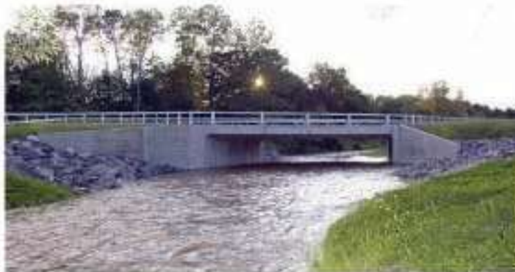
Fig: 1-4-3 Slab culvert
