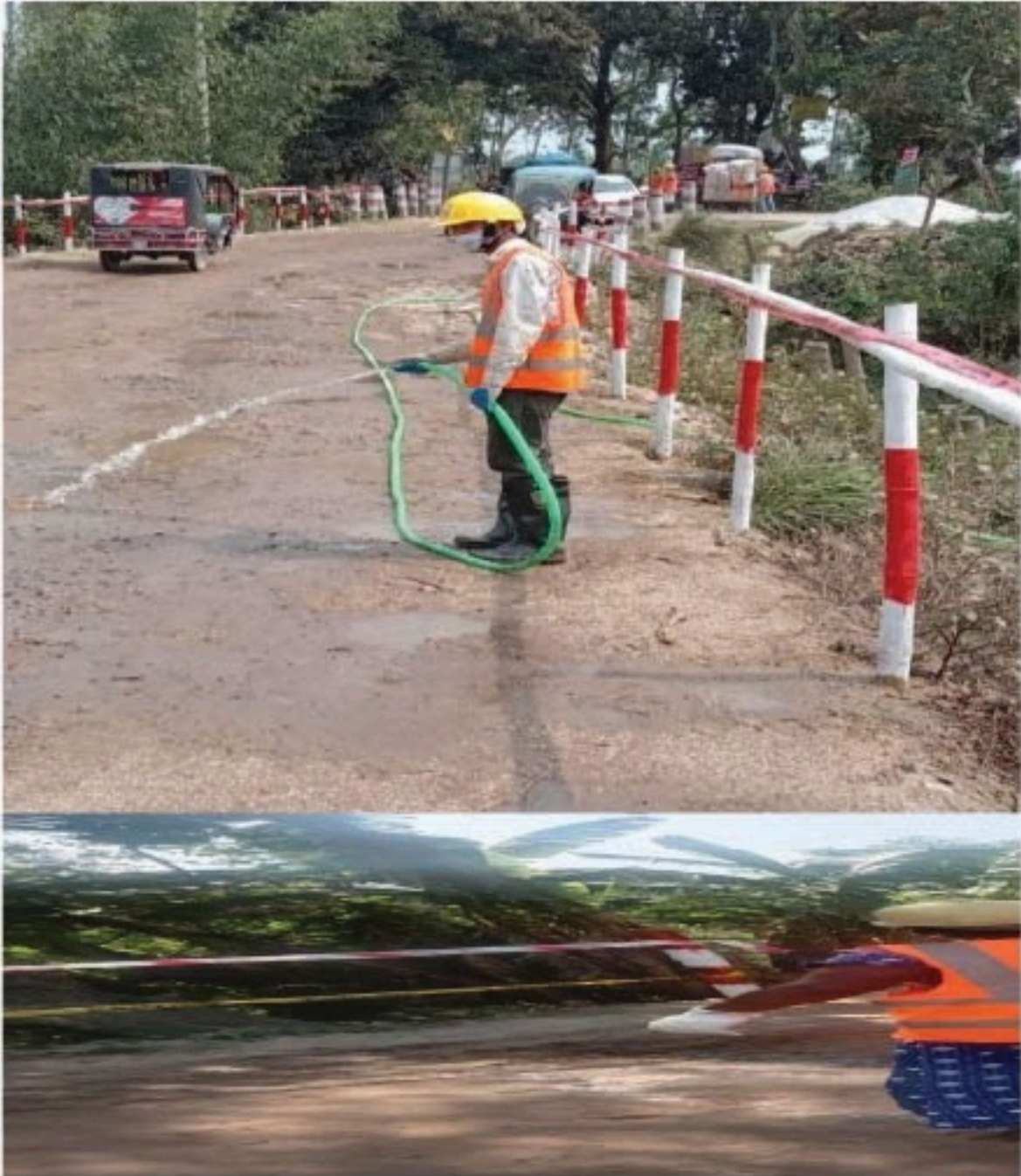
Fig: 4.2 Dust control
