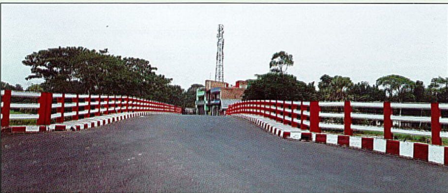
শরীয়তপুর জেলার সদর উপজেলায় আঙ্গারিয়া জিসি-চন্দ্রপুর জিসি ভায়া বিনোদপুর ইউপি সড়কে ৪৫.০৬ মিটার দৈর্ঘ্যের আরসিসি গার্ডার ব্রিজ নির্মাণ
