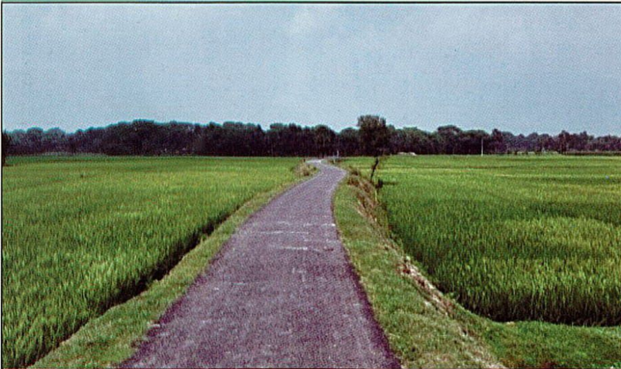
নবনির্মিত বগুড়া জিসি-সিকারপুর বাজার ভায়া বুড়ির হাট সড়ক
