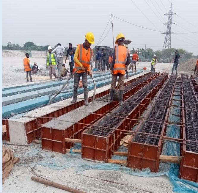
মাথাভাঙ্গা স্যুয়েজ ট্রিটমেন্ট প্ল্যান্ট-এ pre-cast pile এর concreting ও pre-cast pile drive কার্যক্রম
