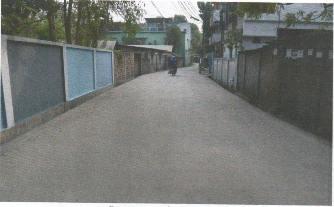
পেটকার বাজার মেইন রোড মেরামত
