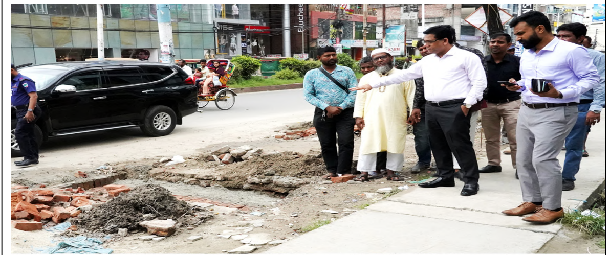
১৩ আগস্ট : নগরীর মজিদ সরণি ও সংলগ্ন উভয় পার্শ্বের ড্রেনের (শিববাড়ি থেকে সোনাডাঙ্গা পর্যন্ত) চলমান উন্নয়ন কাজ পরিদর্শন করেন কেসিসি প্রশাসক মো: ফিরোজ সরকার ।
